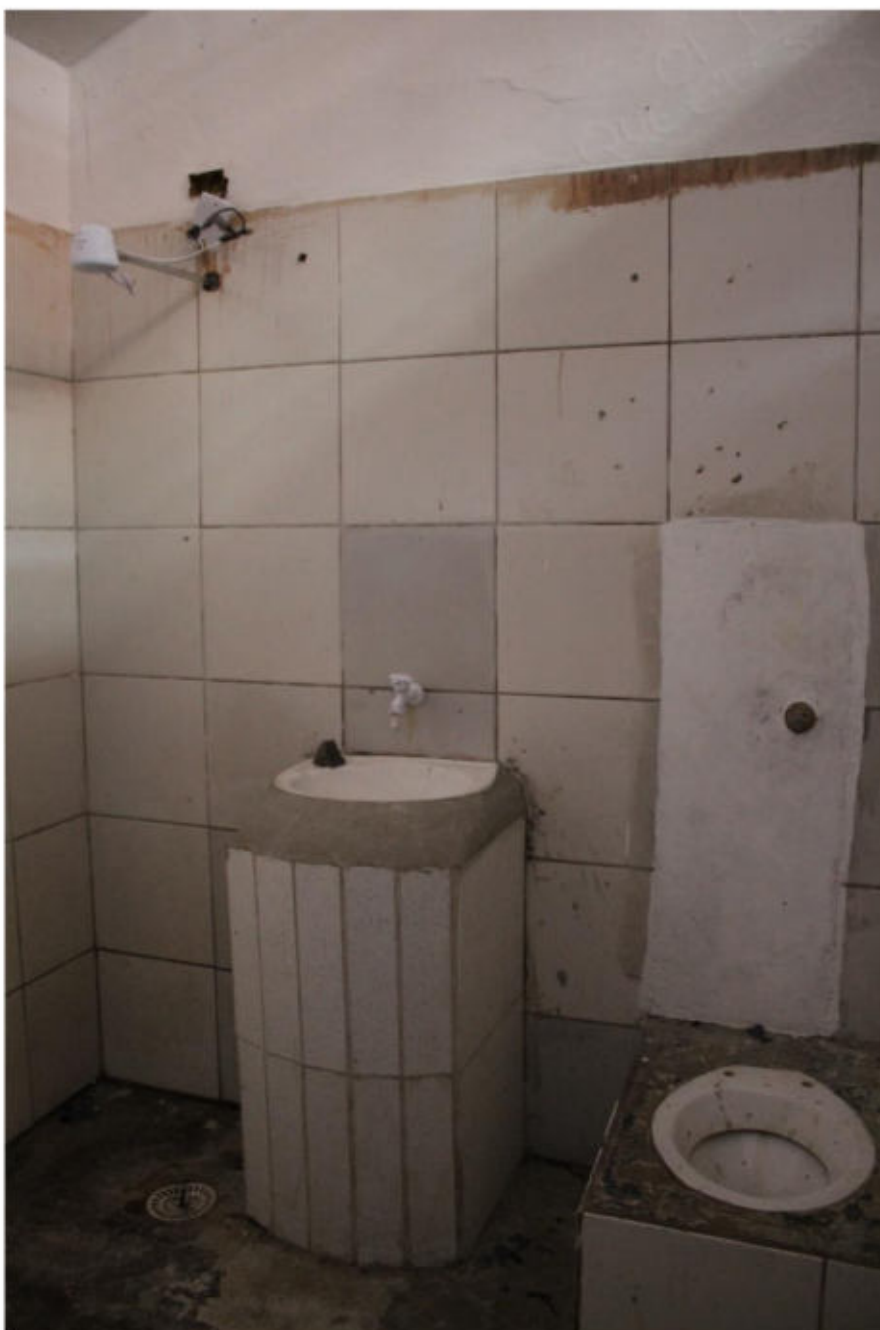
Banheiro no interior da cela do setor disciplinar
