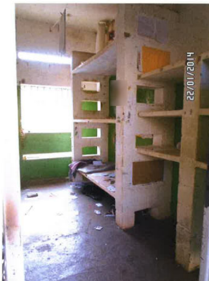
Imagem 14: interior de cela coletiva
