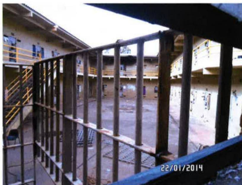
Imagem 36: Vista do raio em que os presos estavam, só foi permitido à Defensoria Pública observar as condições dos presos da janela de um mirante do Presídio.
