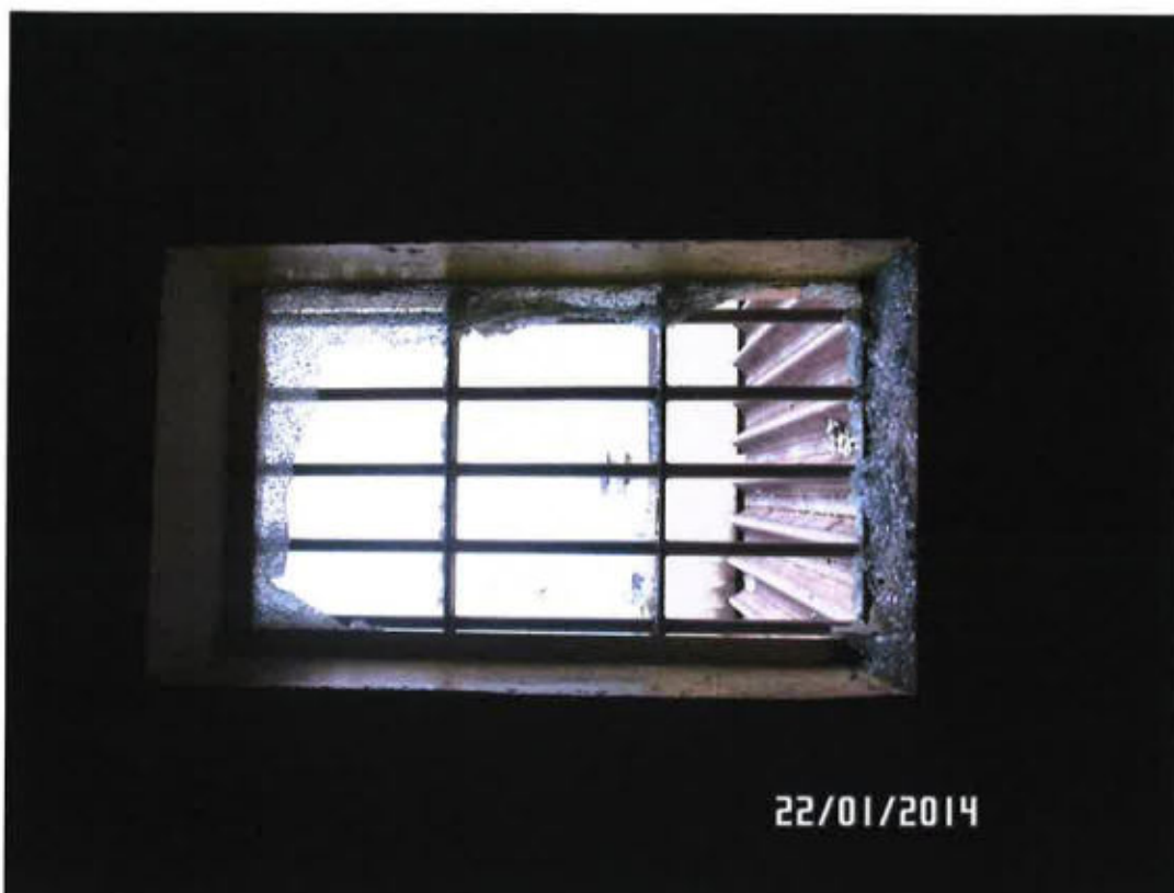
Imagem 4: janela de vidro destruída na rebelião de 13/01/2014
