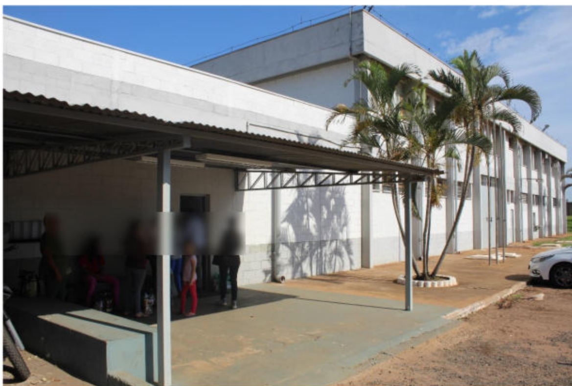
(Local coberto de espera das visitantes para entrada na unidade prisional)
