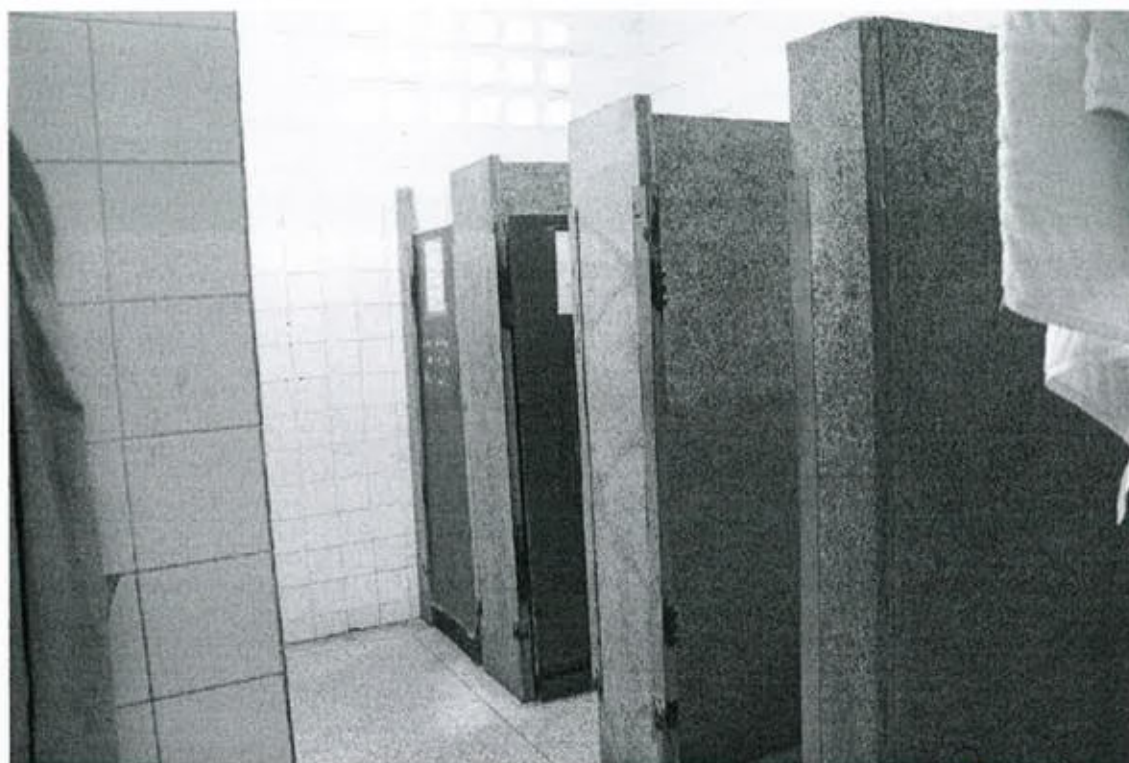
Figura 16. Cabines individuais com sanitário.
