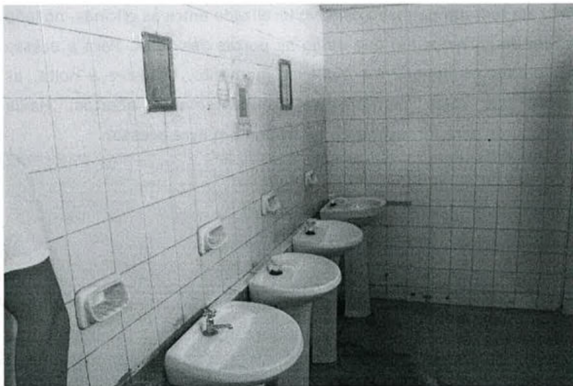
Figura 15. Banheiro de uso coletivo.
