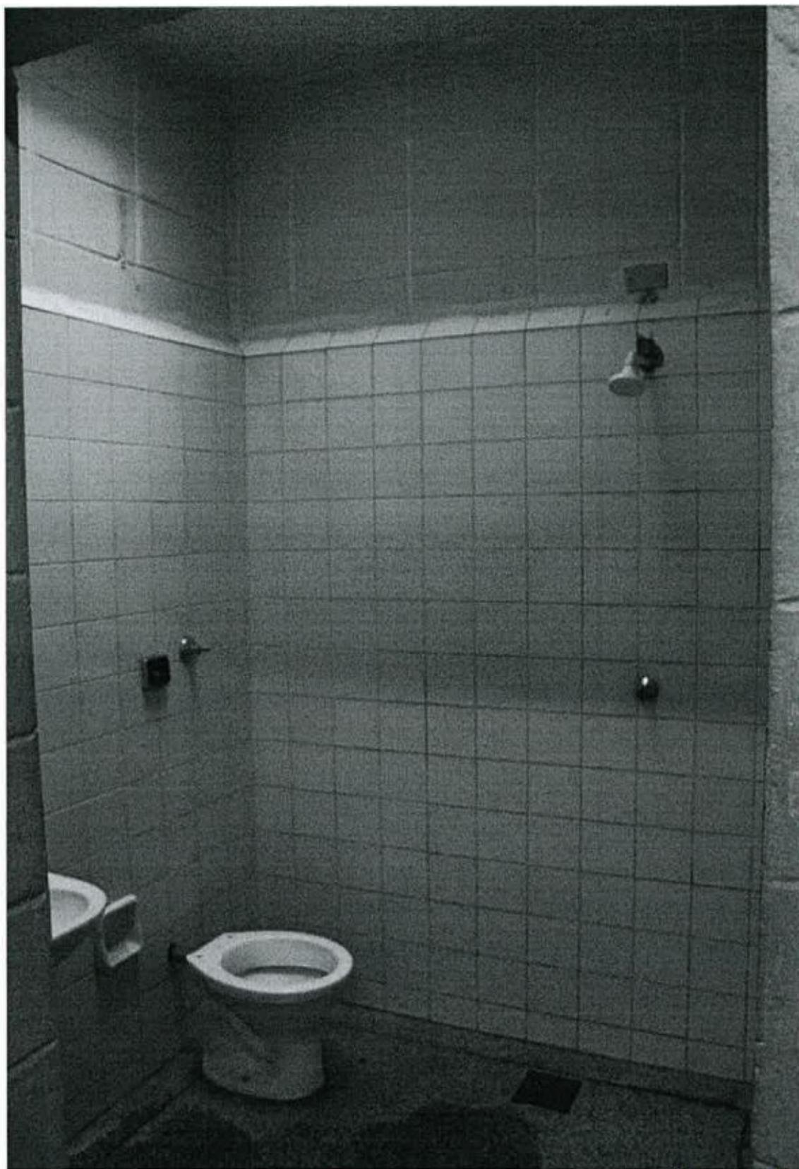
Figura 13. Banheiro da cela de isolamento.
