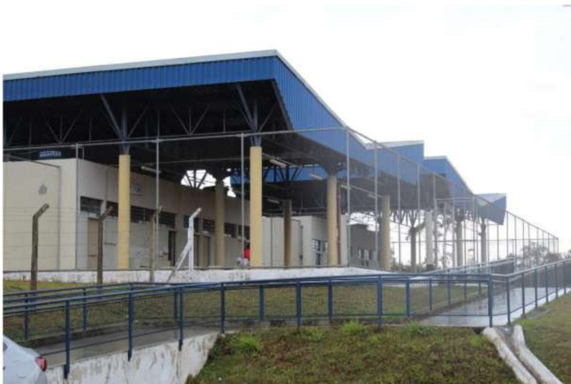
Cobertura destinada aos visitantes vista de perto
