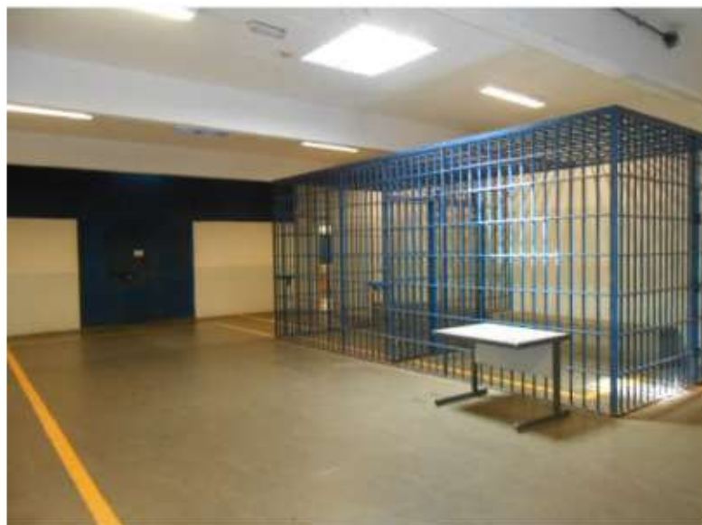
Cela de contenção (Trânsito e atendimento)
