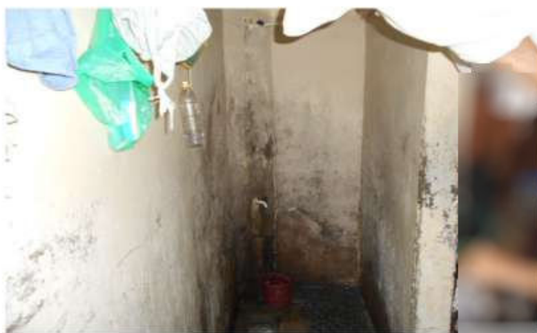
Área do chuveiro (interior da cela)
