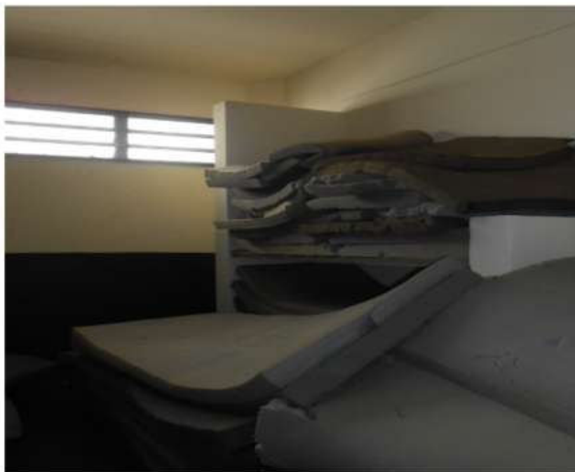
Sala de armazenamento de colchões
