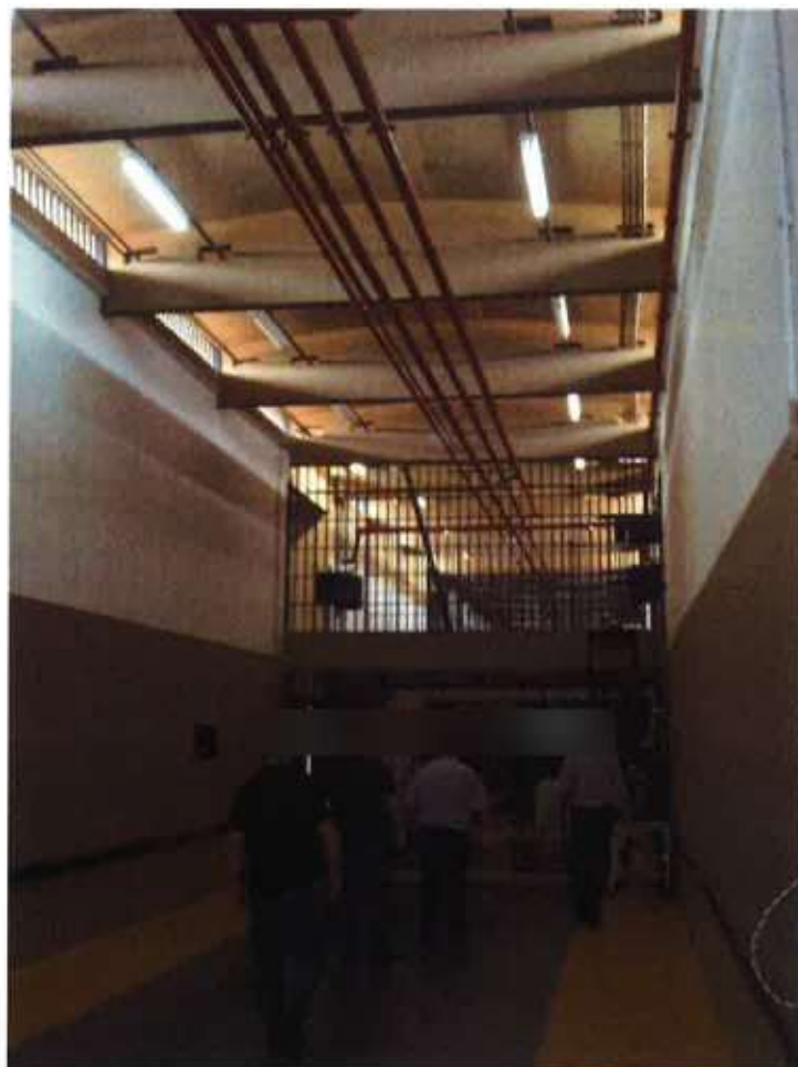
Foto 45 – Adentrando outros raios no pavilhão.
