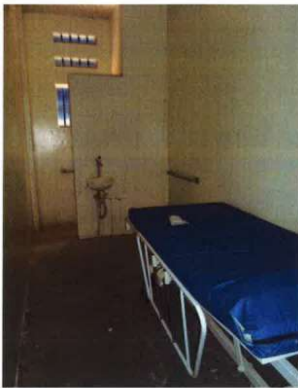
Foto 15 - Cella do setor de enfermaria. as celas não eram escuras e estavam em estado regular de conservação.
