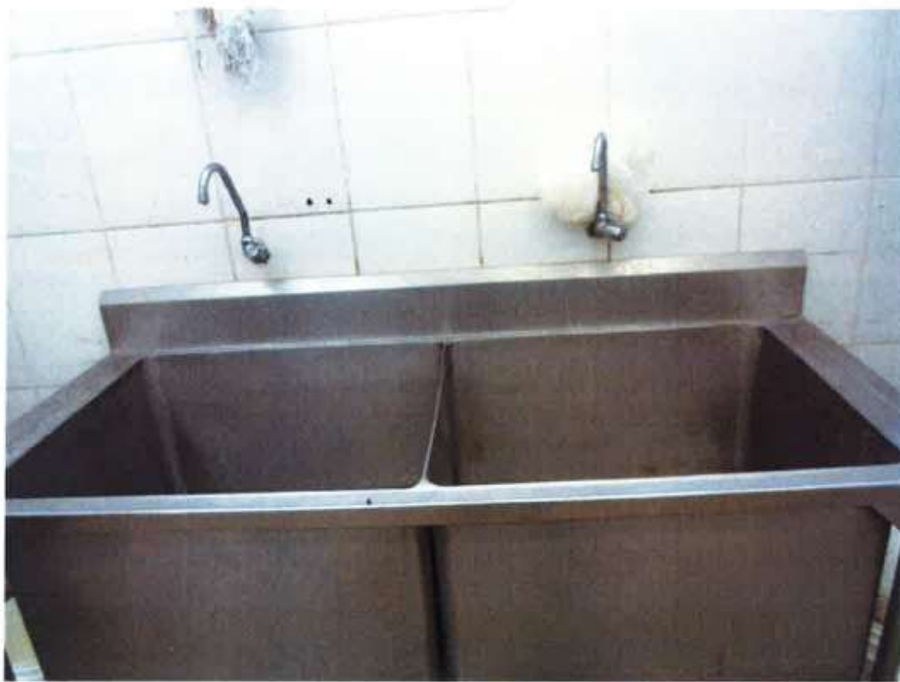
Foto 7 - Lavatório da cozinha.
