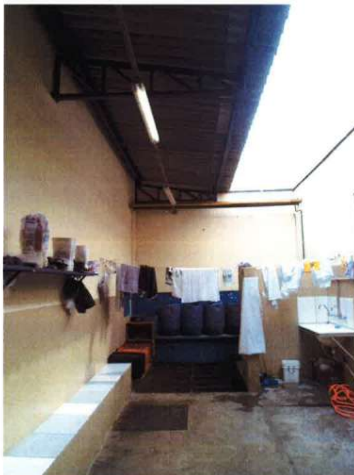
Foto 44 – Parte posterior da cozinha contendo lavatório e mantimentos de limpeza.
