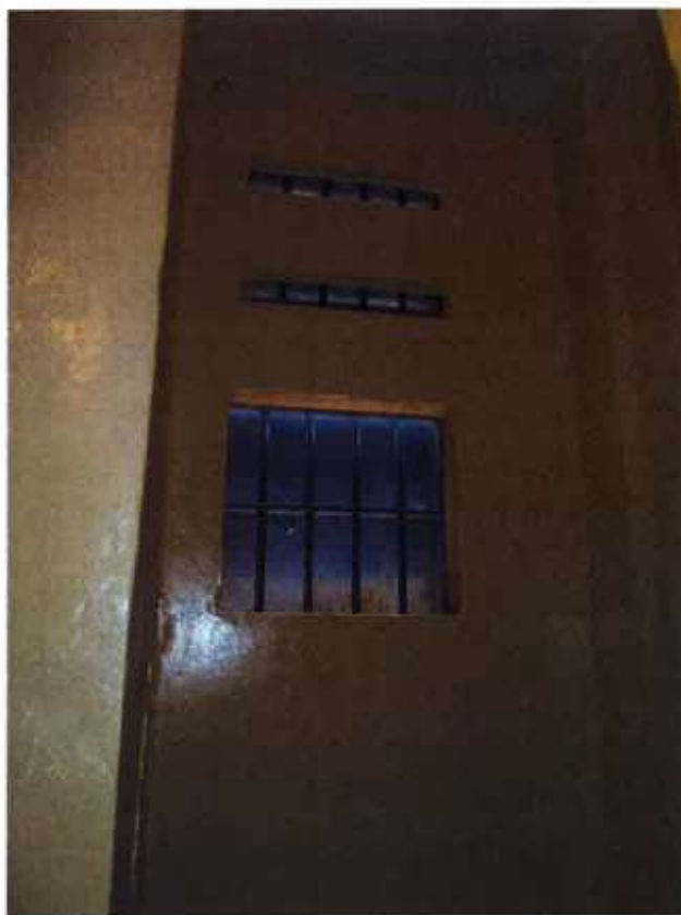
Foto 21 - Grade da cela do setor de inclusão.
