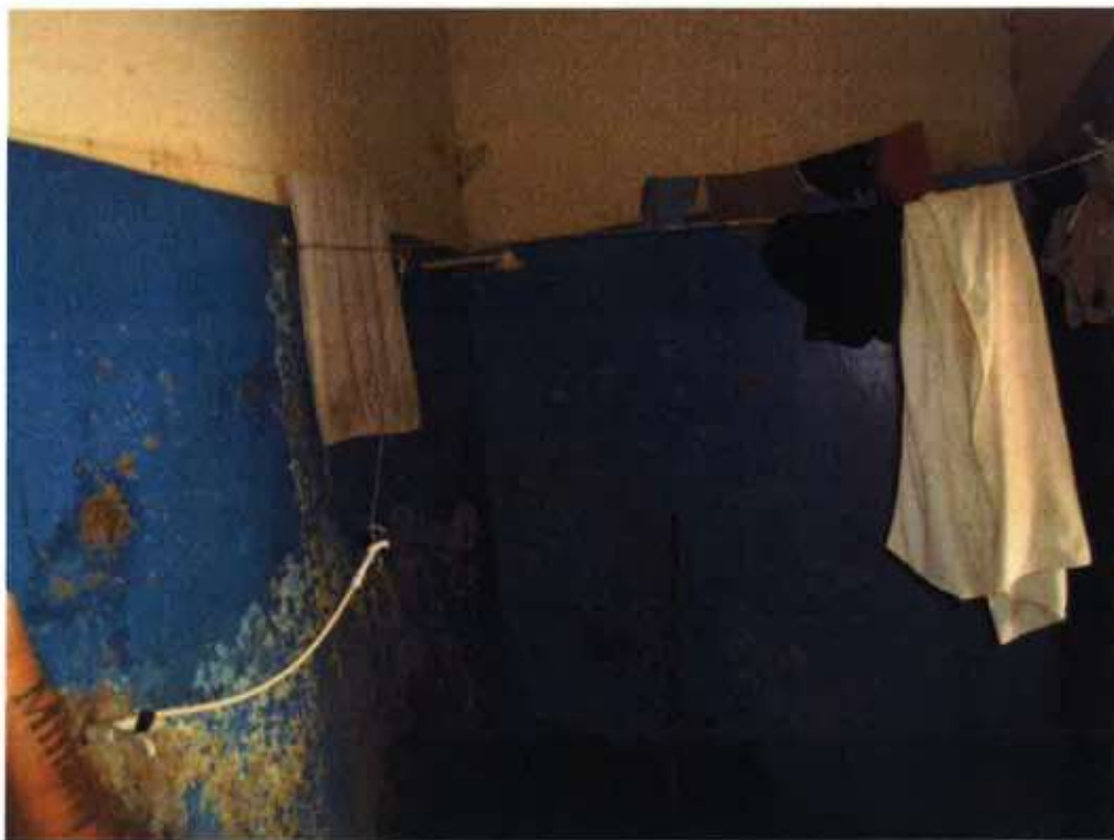
Foto 53 – Cella úmida e chuveiro de água fria.
