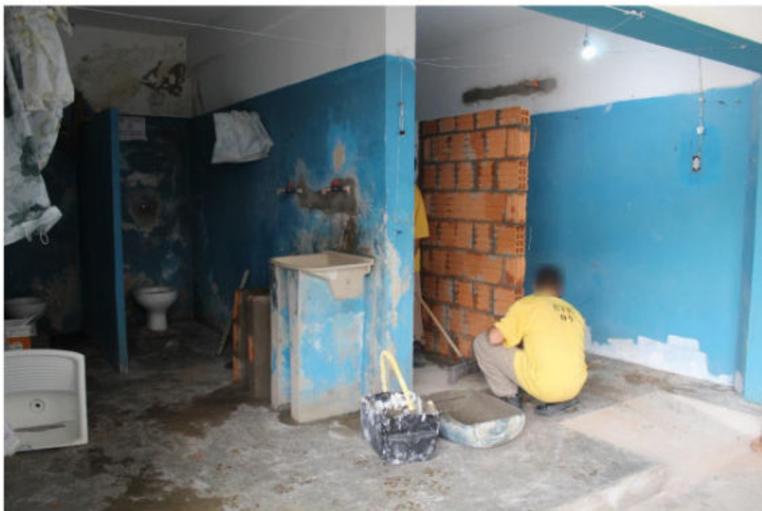
Foto 4: obras para instalações dos chuveiros quentes no Raio 1
