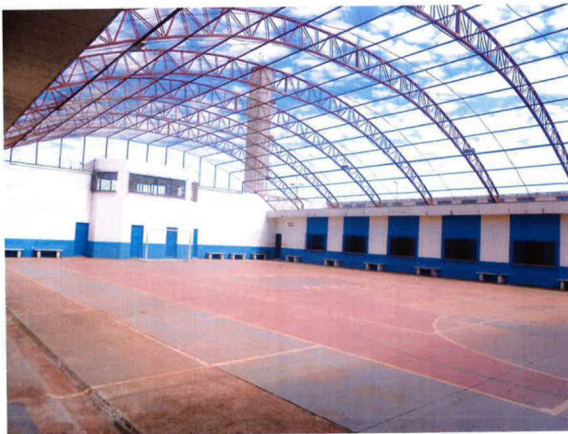
Pátio para banho de sol do setor convívio (2)
