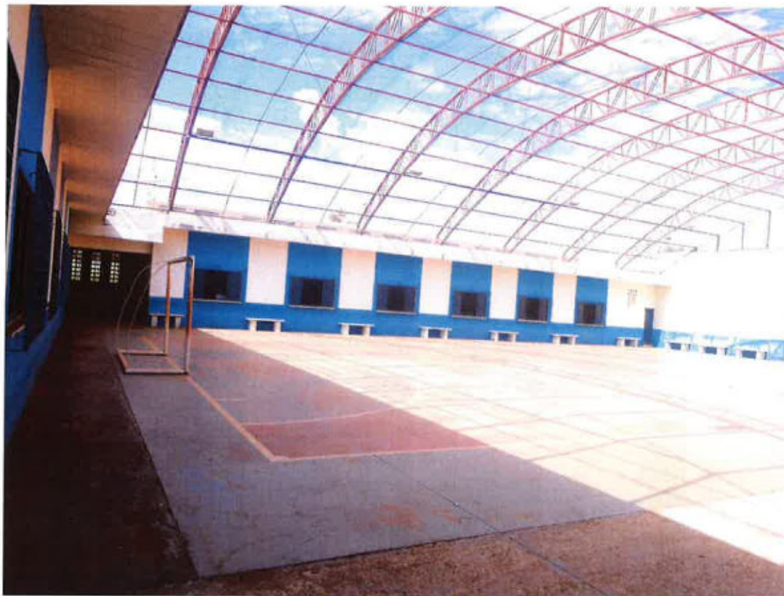
Pátio para banho de sol do setor convívio (3)
