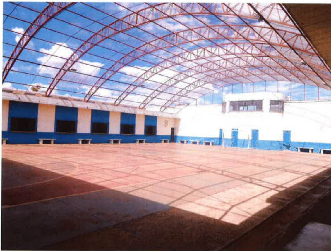
Pátio para banho de sol do setor convívio (1)
