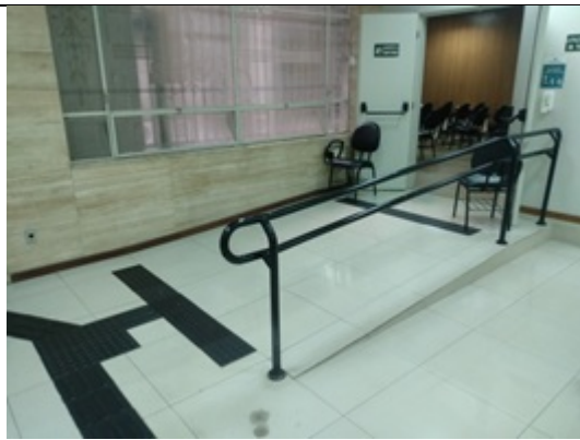
Foto 6 – Rampa de acesso ao auditório, com inclinação e dimensões adequadas, corrimão e sinalização tátil de alerta.
