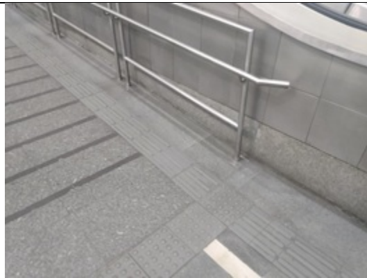
Foto 4 – Possui rampa, com inclinação e dimensões adequadas, corrimão e sinalização tátil direcional e alerta.
