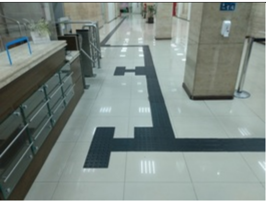
Foto 5 – Sinalização tátil direcional e alerta em todo o percurso até o auditório;
