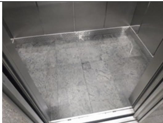
Foto 6 – Possui elevadores com dimensões adequadas;
