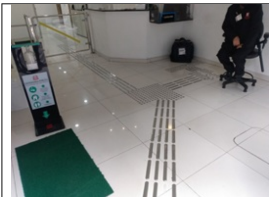
Foto 1 – Acesso principal possui piso regular e livre de obstáculos, sinalização tátil direcional e alerta em todo o percurso;
