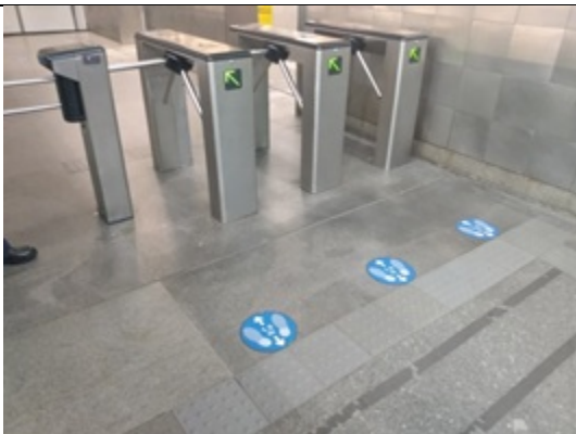
Foto 5 – Possui catraca acessível;
