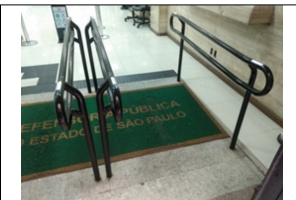
Foto 2 – Rampa do acesso principal, com inclinação e dimensões adequadas, corrimão e sinalização tátil de alerta;
