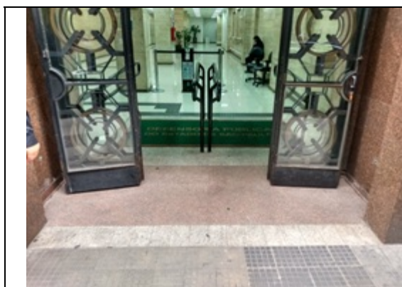
Foto 1 – Acesso principal possui piso regular e livre de obstáculos;
