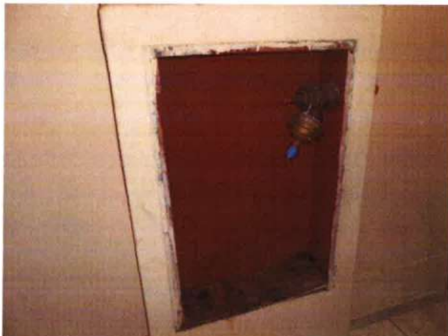
Hidrante sem mangueira
