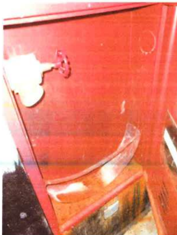
Hidrante sem mangueira
