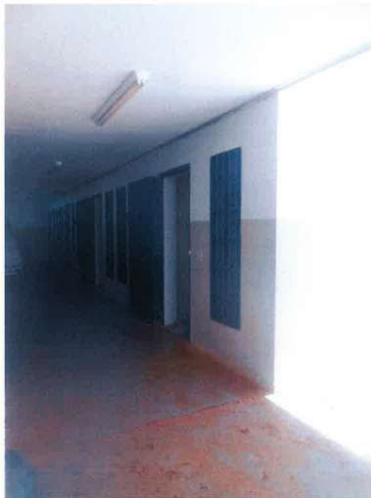
Foto 07 – Celas de enfermaria – Visão externa
