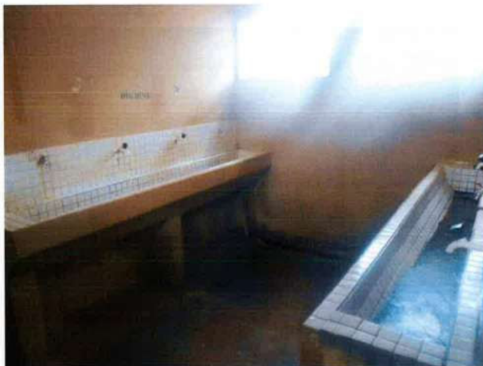
Foto 36 – Banheiro do alojamento
