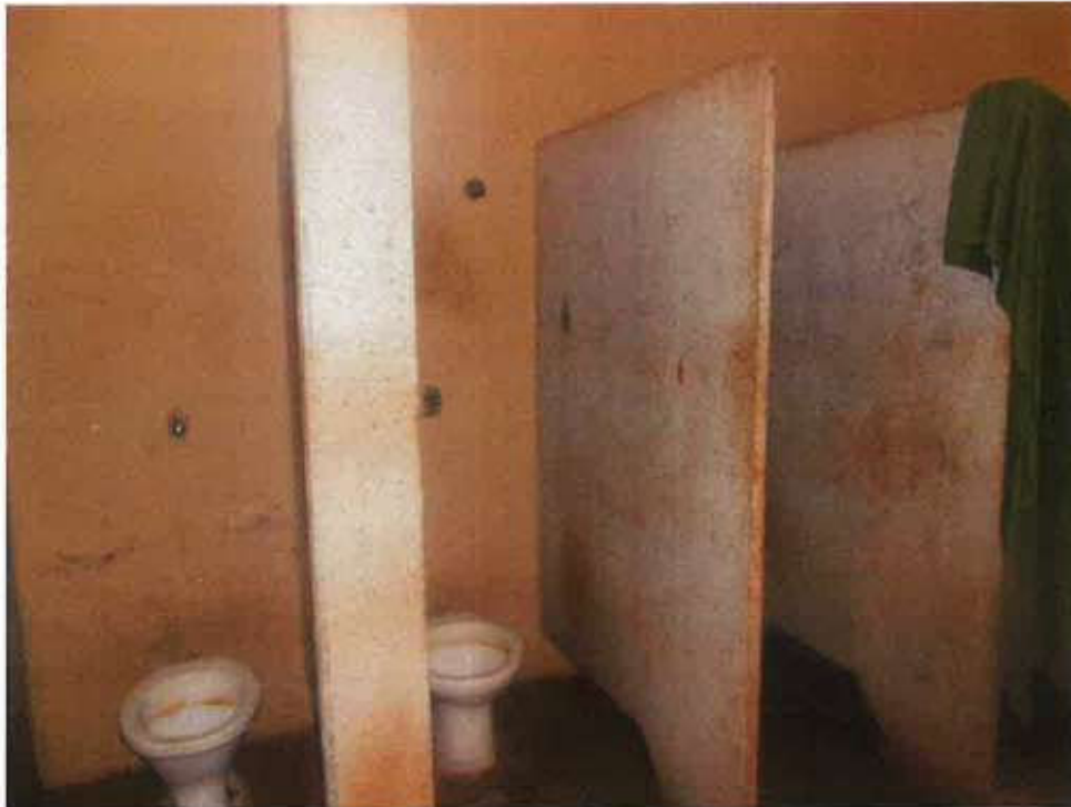
Foto 38 – Banheiro do alojamento [3]
