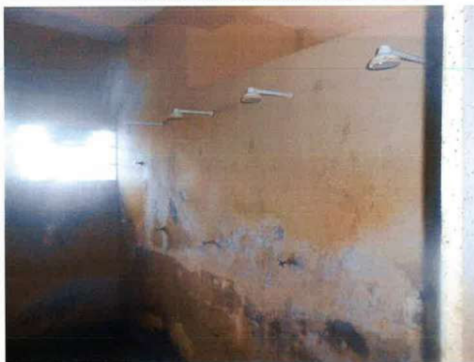
Foto 37 – Banheiro do alojamento [2]
