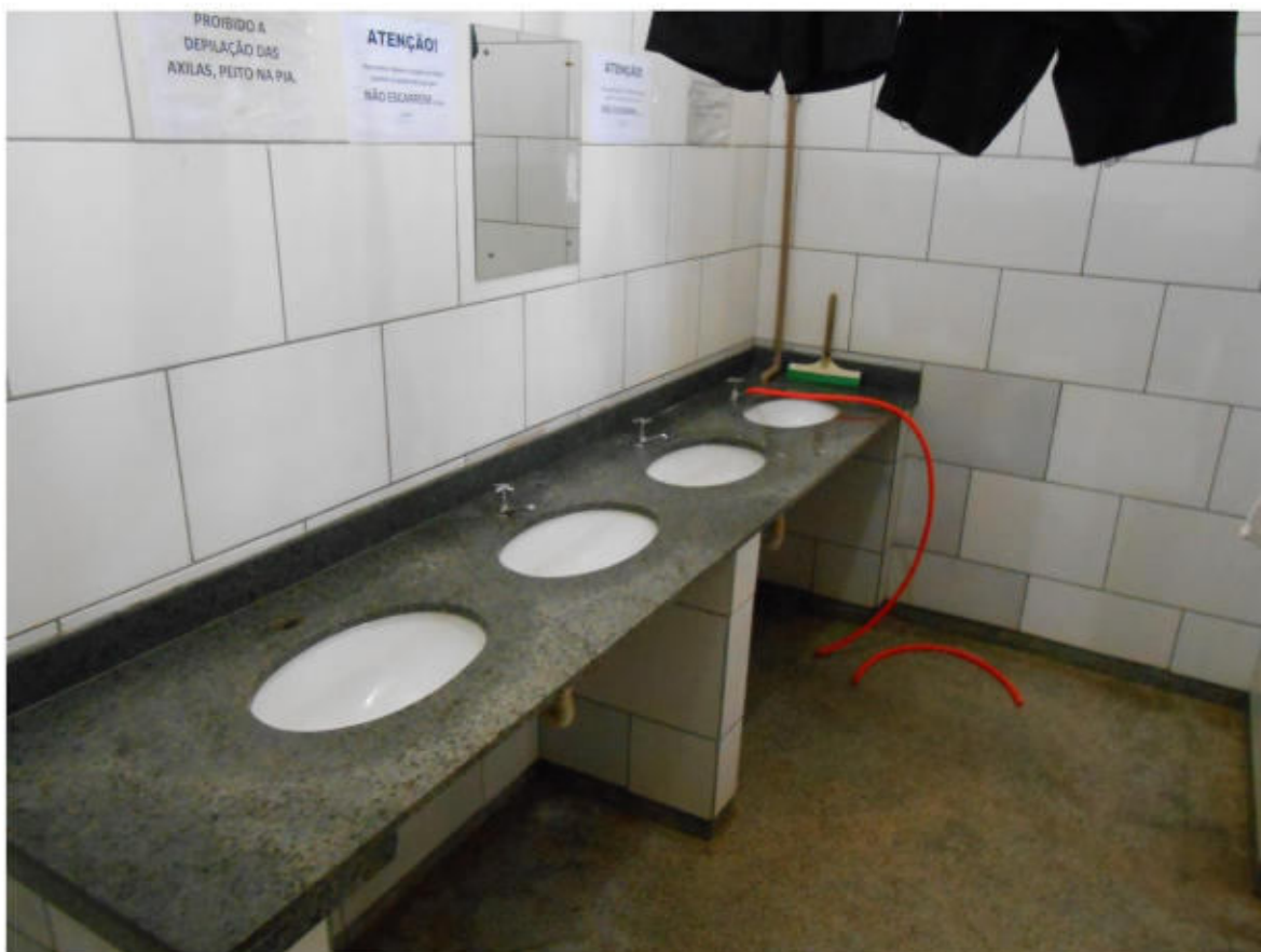
Figura 6. Instalações de um dos banheiros utilizados pelos presos.
