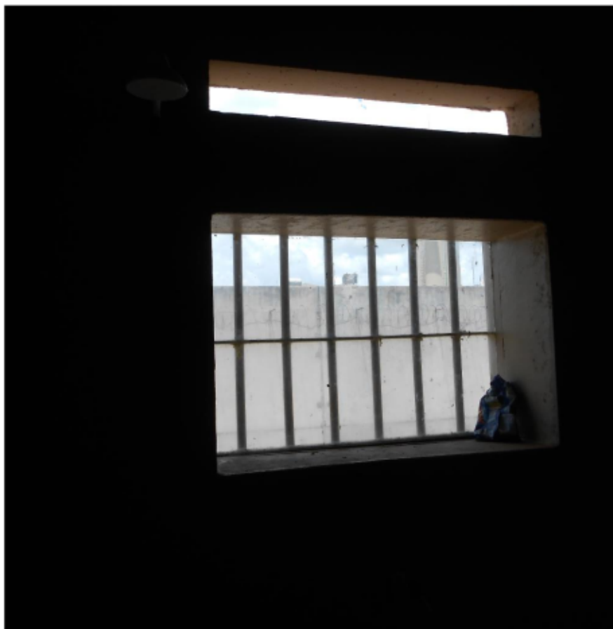
Figura 17. Entrada insuficiente de luz e ventilação na cela de seguro. Havia vidros totalmente fechados e fixos na parte inferior.
