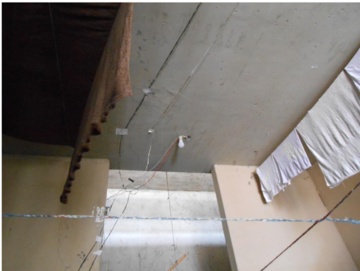
Figura 11. Ligações irregulares de energia. Segundo a direção, é feita pelos próprios presos.
