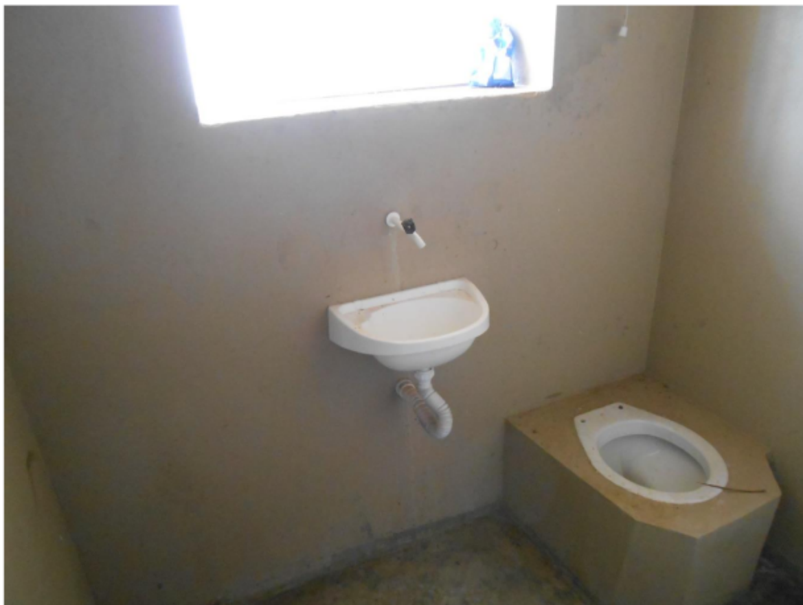
Figura 16. Banheiro da cela de seguro.
