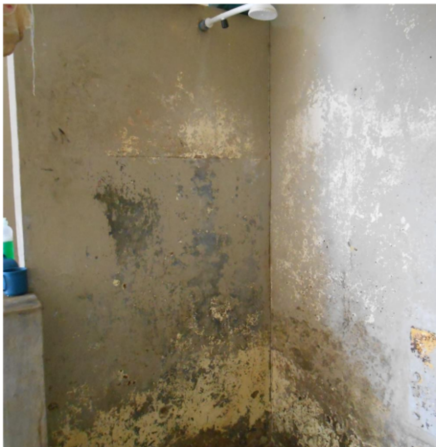
Figura 4. Banheiro no pátio do Raio 08.
