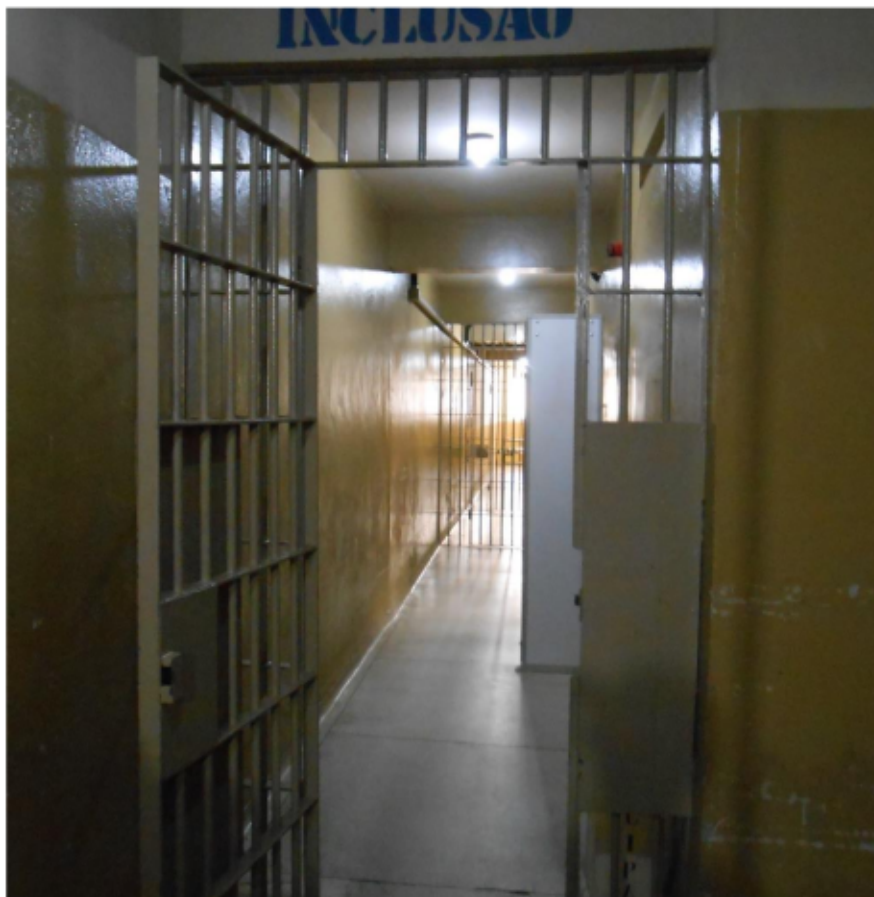
Figura 21. Corredor que dá acesso às celas da inclusão.
