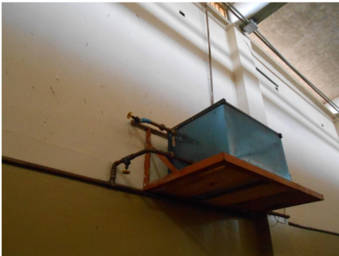
Figura 26. Reservatórios de água potável gelada que ficam no corredor de acesso ao raio do convívio. Há um destes reservatórios para cada raio e os presos tem acesso a água através de uma torneira instalada no pátio.
