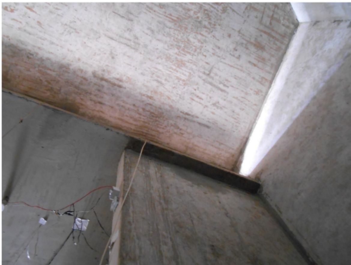
Figura 13. Entrada de luz e ventilação das celas se dá somente por uma pequena abertura localizada acima dos sanitários e pelas grades voltadas ao pátio interno..
