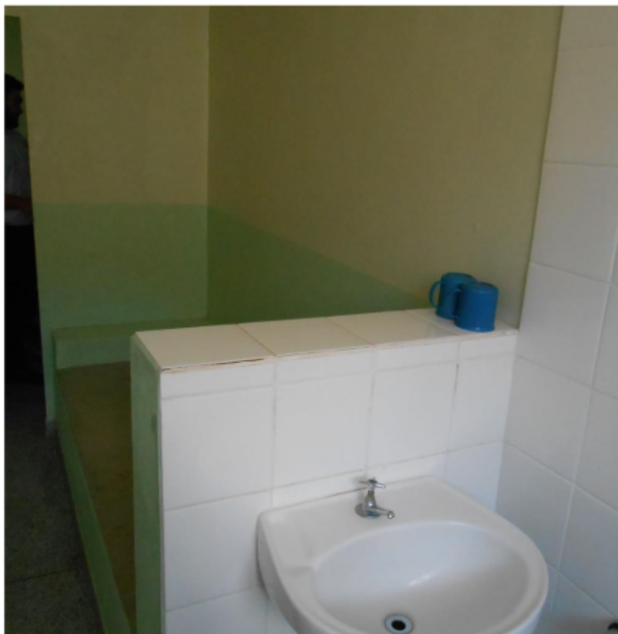
Figura 36. Detalhe das instalações sanitárias da cela da enfermaria.
