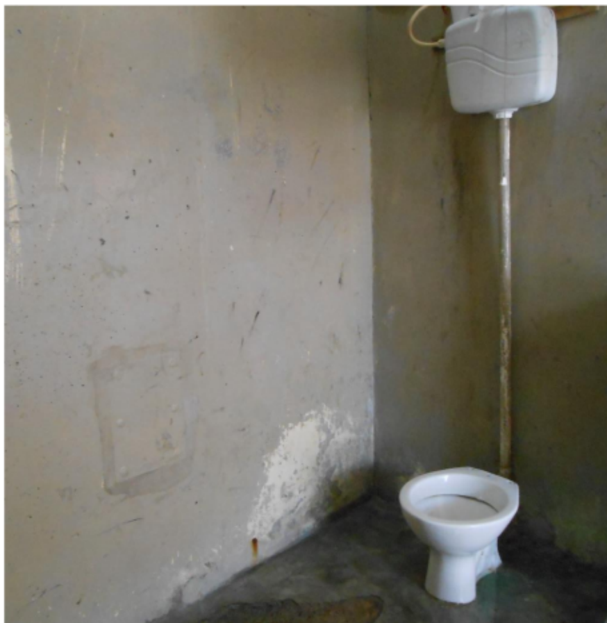
Figura 3. Banheiro no pátio do Raio 08.
