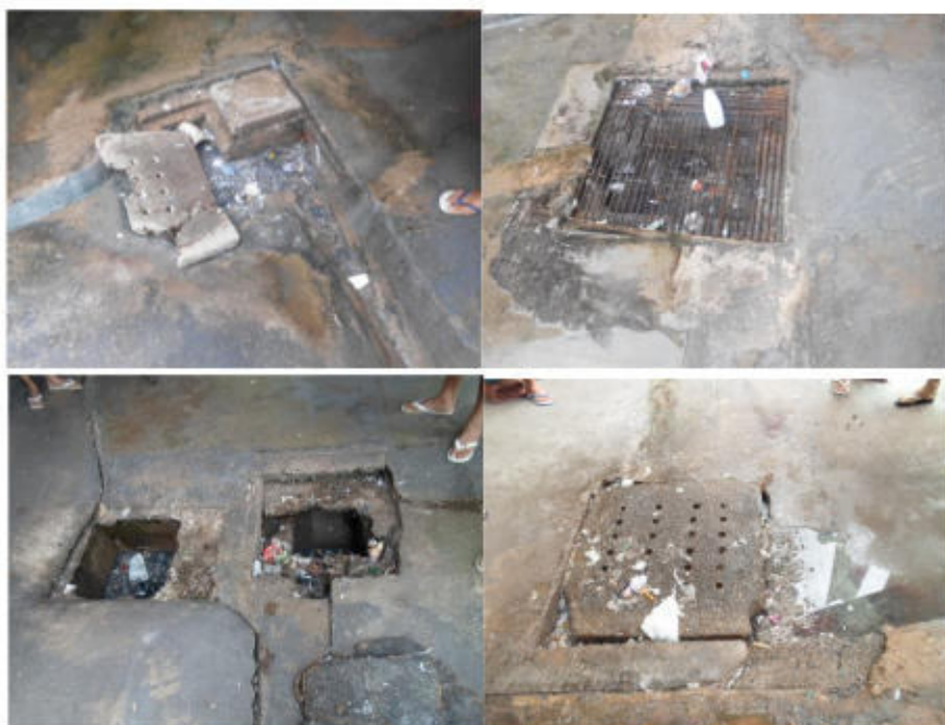
(ralos abertos, os quais inundam e retornam esgoto)
