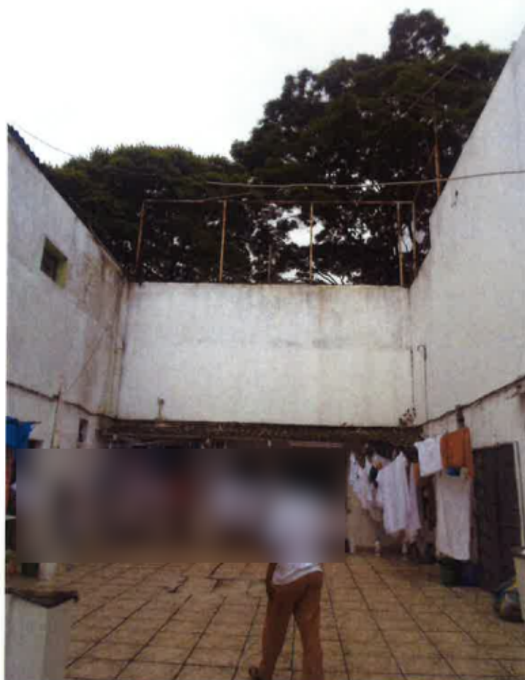
Cobertura na frente do pátio.
