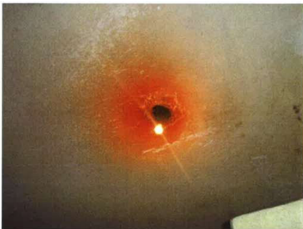
Iluminação precária na cela da inclusão
