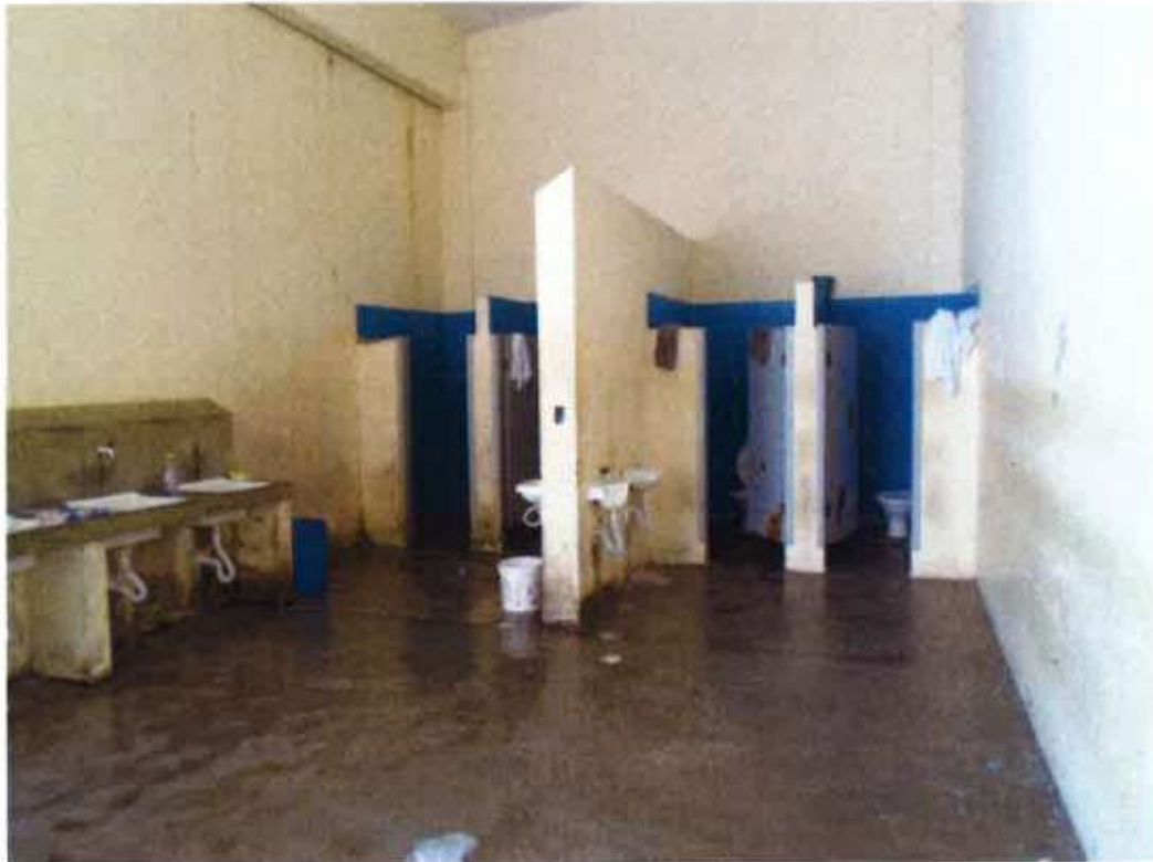
Banheiro e tanques no raio
