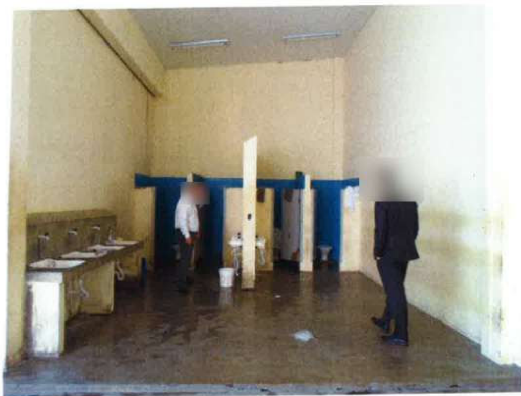
Banheiro e tanques no raio
