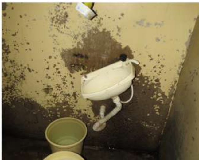
Torneira quebrada no interior de uma cela
