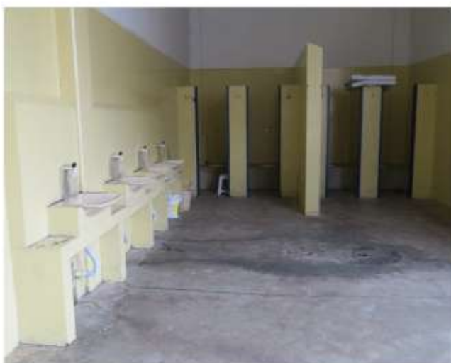
Banheiro comum do raio
