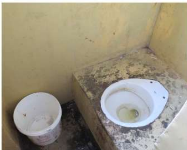
Sanitário de cela de inclusão
