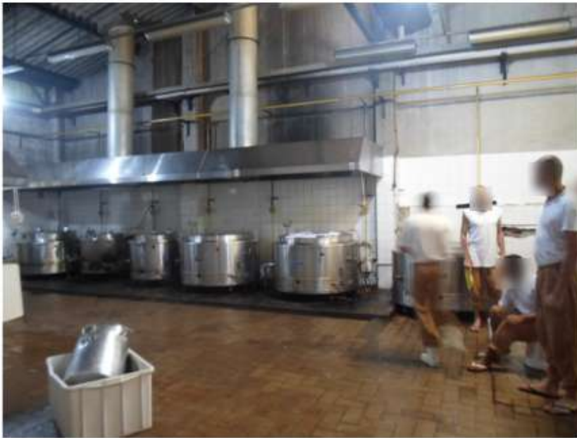
Interior da cozinha
