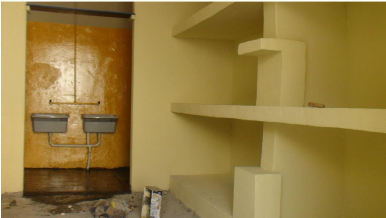
7 – Cella em reforma.
