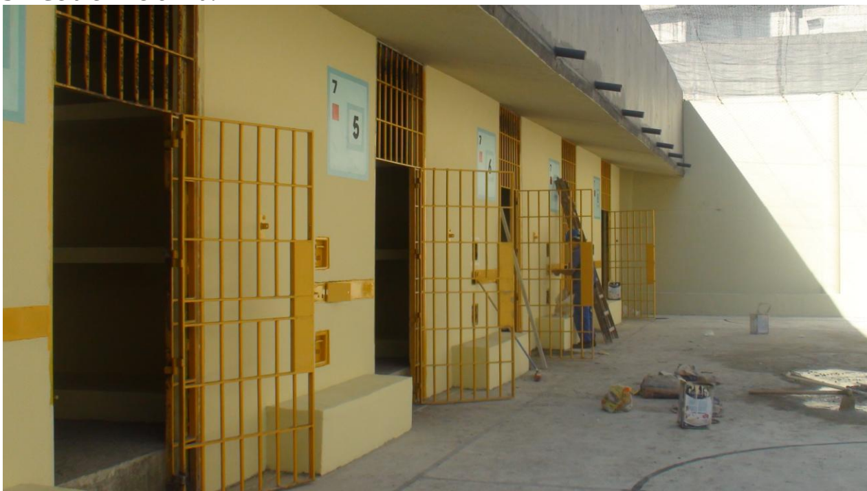
6 – Cella em reforma.
