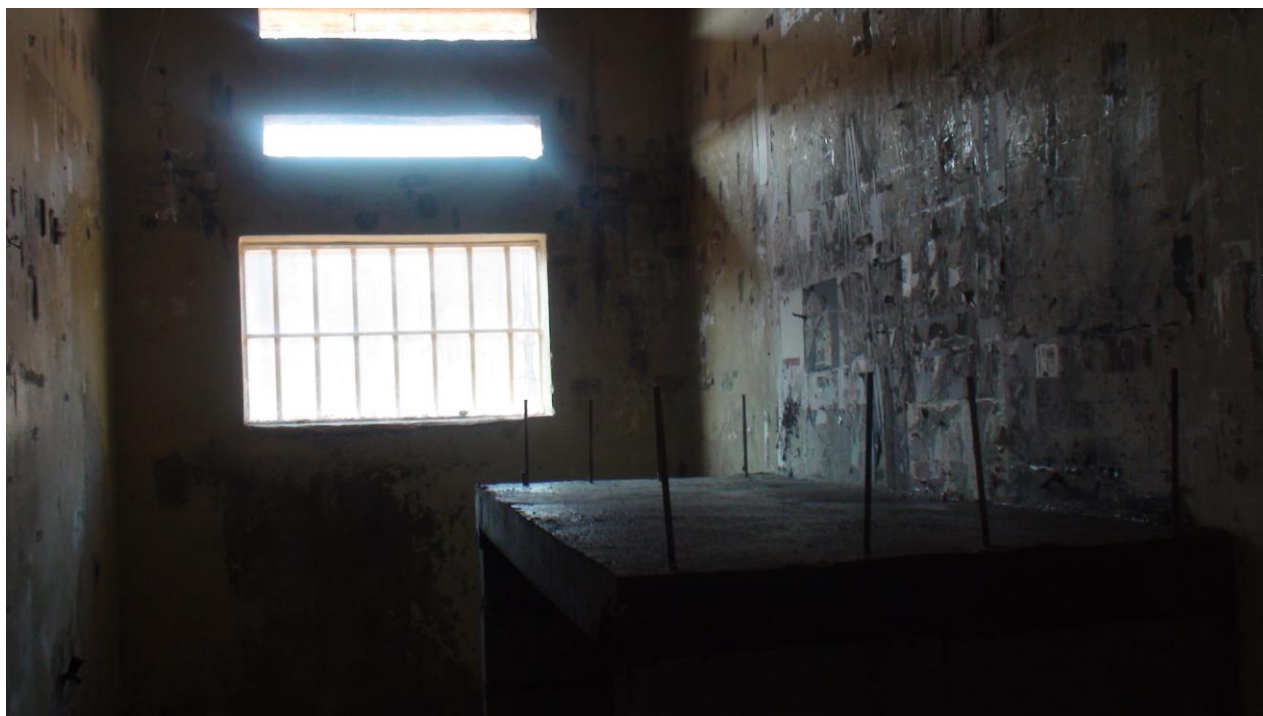
13 – Cela do “seguro” desativada para obras.
