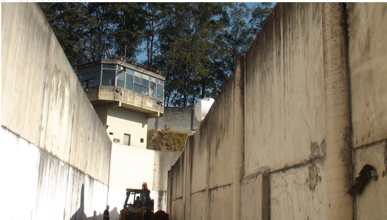
4 – Área externa aos raiois em obra.
