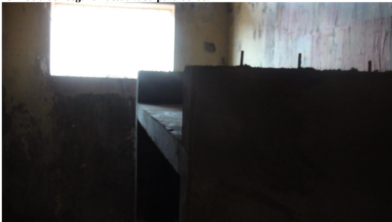
14 - Cela do “seguro” desativada para obras.
