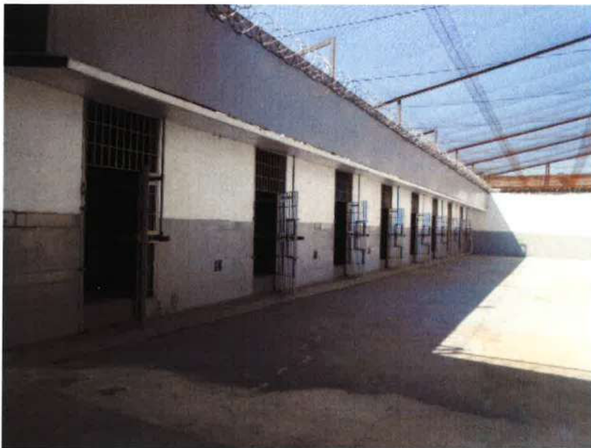
Figura 17 Pavilhão (raio) desocupado e em reforma 01
