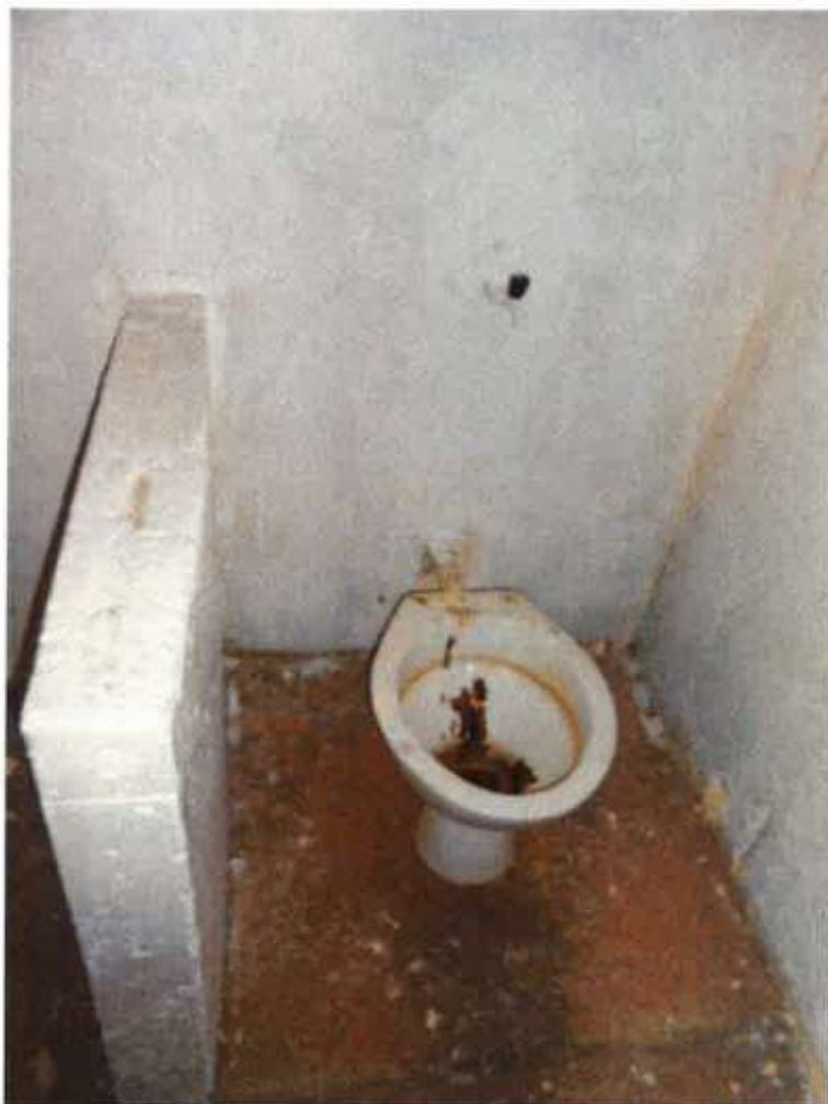
Figura 22 Banheiro da cela do Pavilhão desocupado 03
