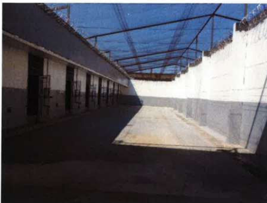
Figura 18 Pavilhão (raio) desocupado e em reforma 02
