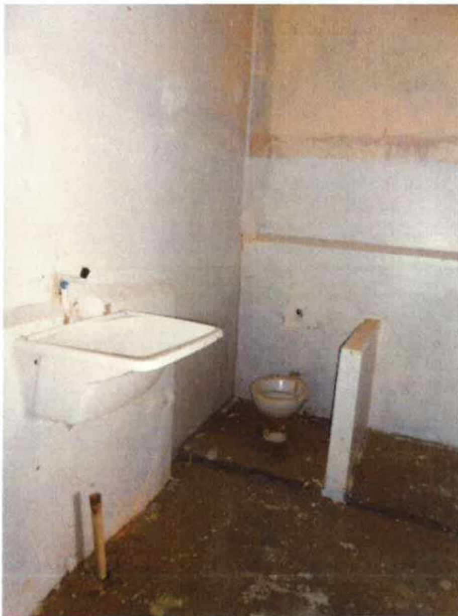
Figura 20 Banheiro da cela do Pavilhão desocupado 01
