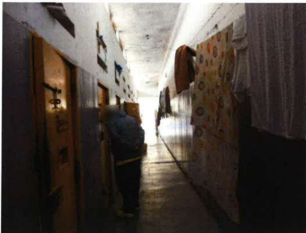
Figura 13 Corredor das celas do Seguro que dá para o pátio
