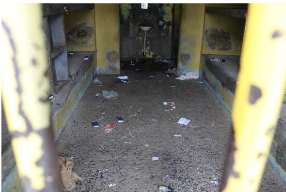
(Cela do Pavilhão 7 com instalações precárias)
