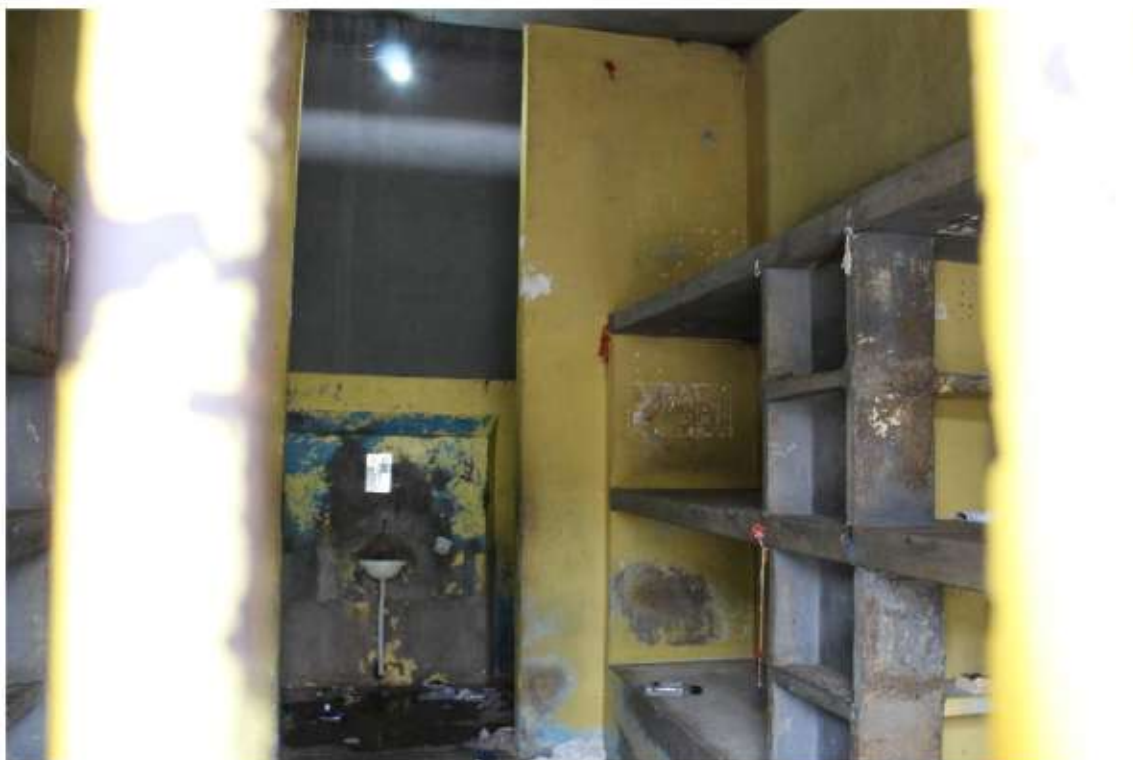
(Cela do Pavilhão 7 com instalações precárias)
