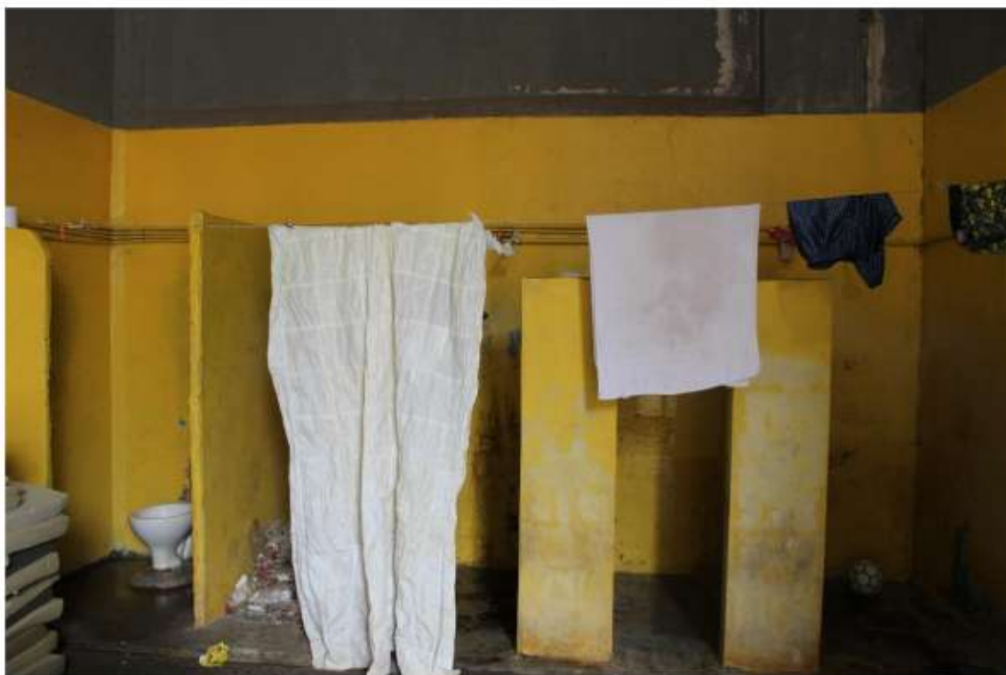
(Banheiro coletivo do Raio 7)
