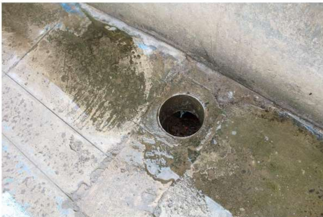
(Ralo aberto no chão do pátio do Raio 7)
