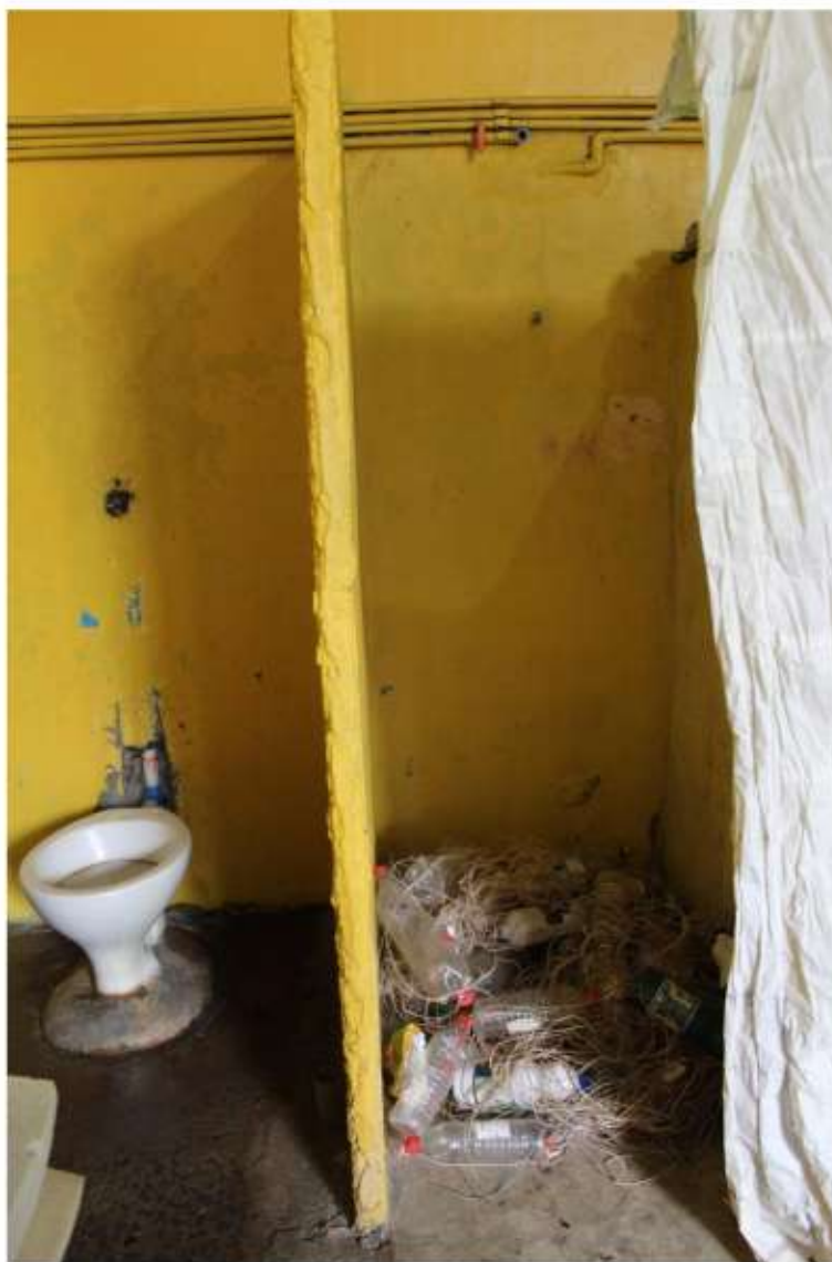
(Banheiro coletivo do Raio 7)
