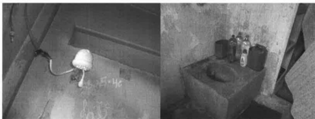
Chuveiro e sanitário no interior da cela
