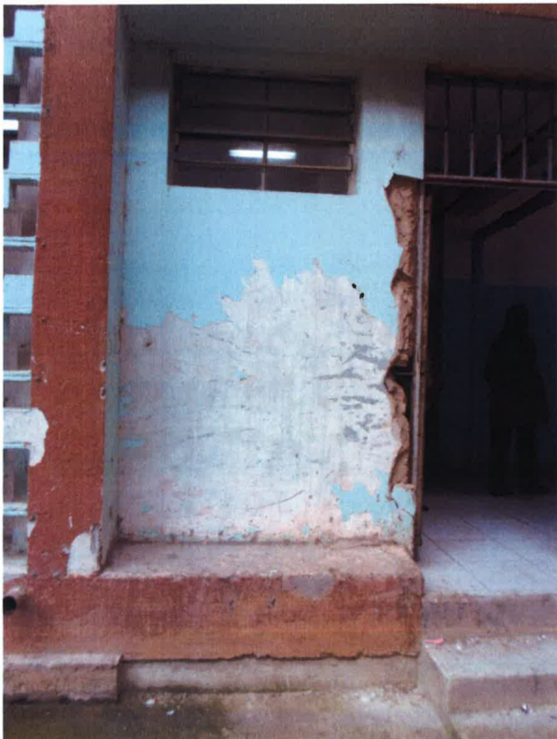
Entrada do edifício
