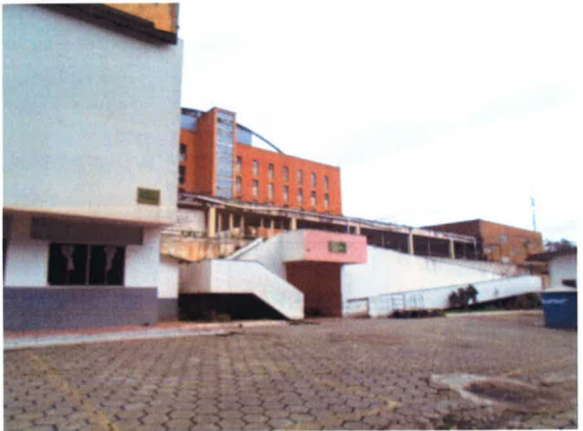
Visão externa dos edifícios da unidade
