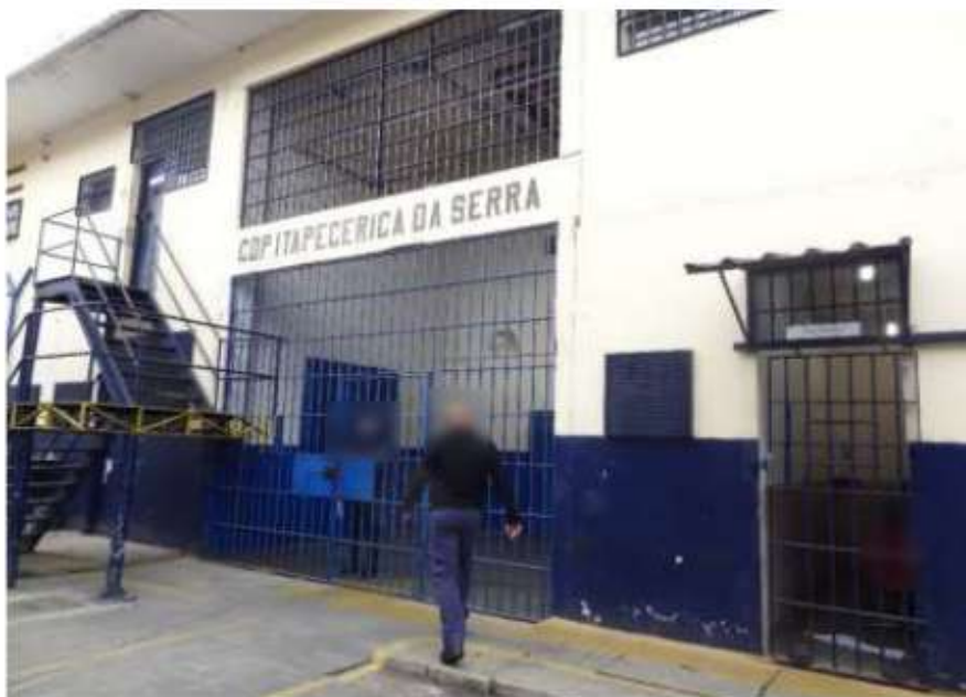
Vista interna do CDP (Intervalo entre o prédio da administração e aquele onde estão concentrados os presos)
