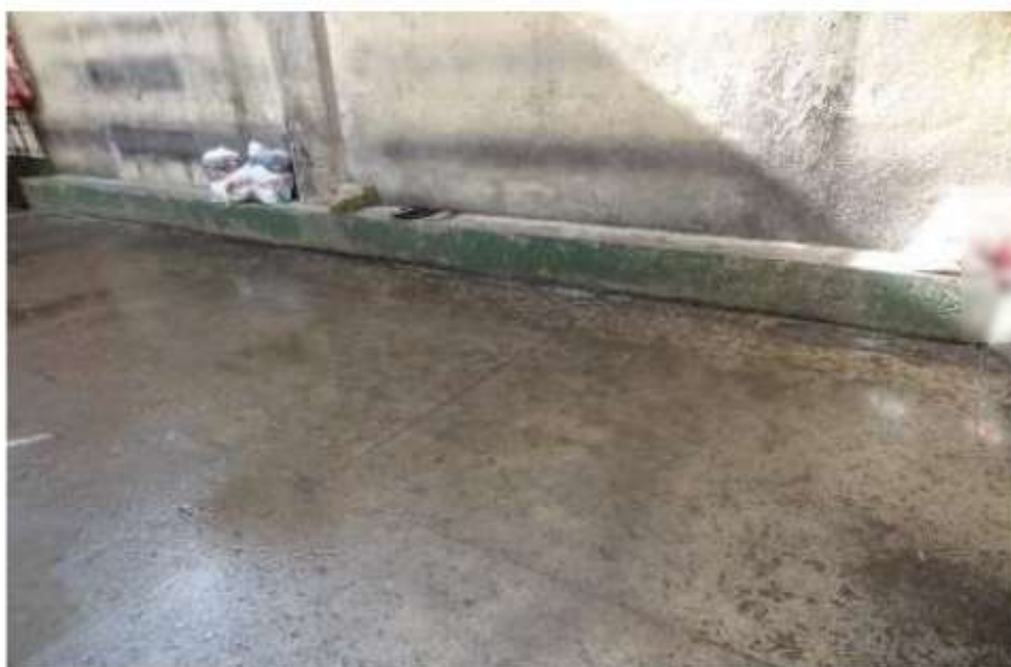
Infiltrações nas celas dos raios 1 e 6
