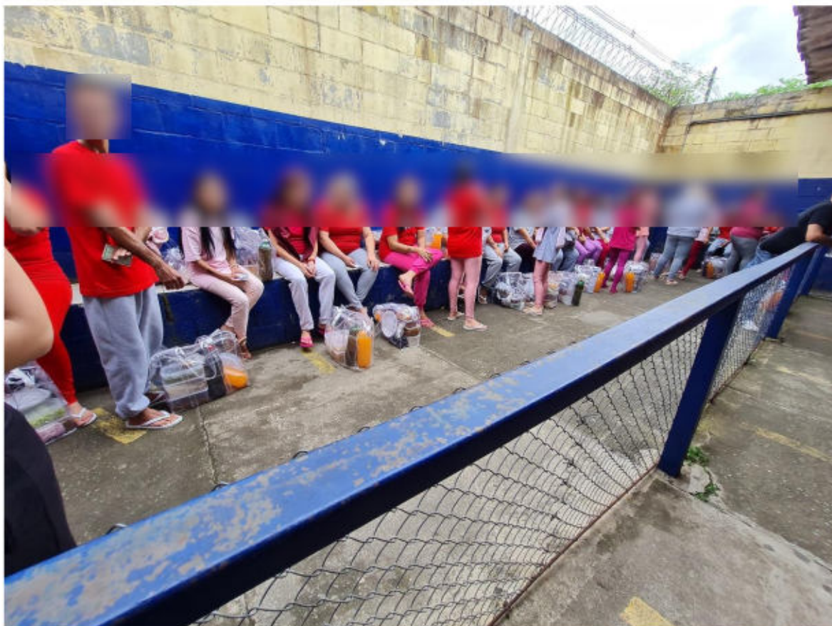
Banco de alvenaria (início da fila para entrada da visitação). Espaço sem cobertura.
