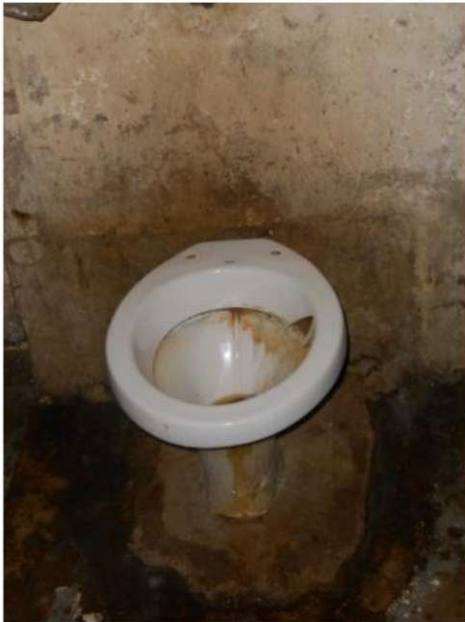
Sanitário do Pátio de Sol
