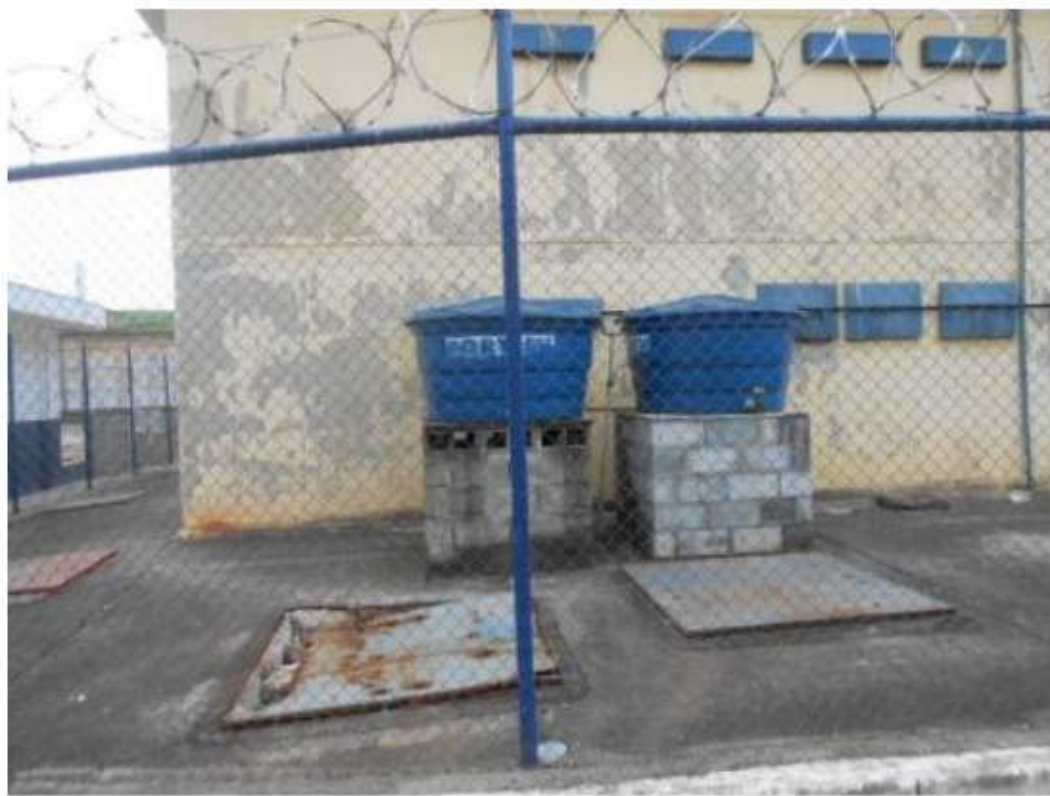
Vista Externa do Pavilhão – Caixas d'Água
