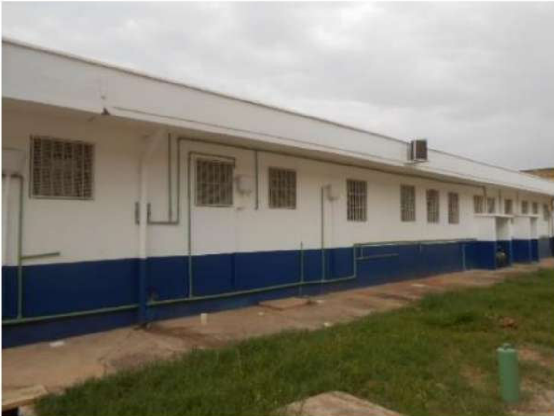
Vista externa do prédio onde ficam o setor de enfermagem, inclusão e seguro
