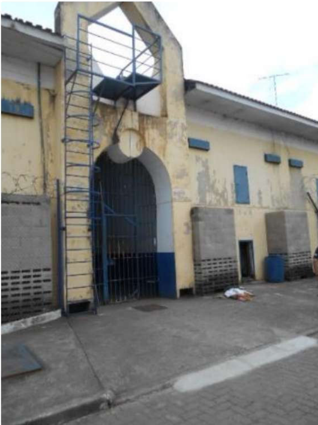
Vista Externa do Pavilhão
