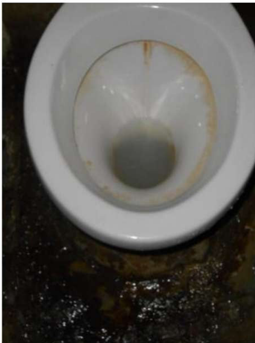
Sanitário do Pátio de Sol
