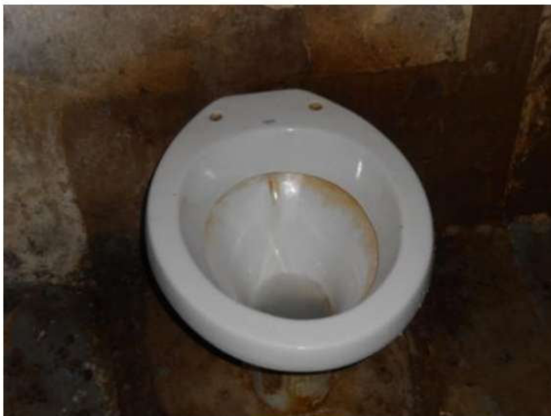
Sanitários do pátio de sol
