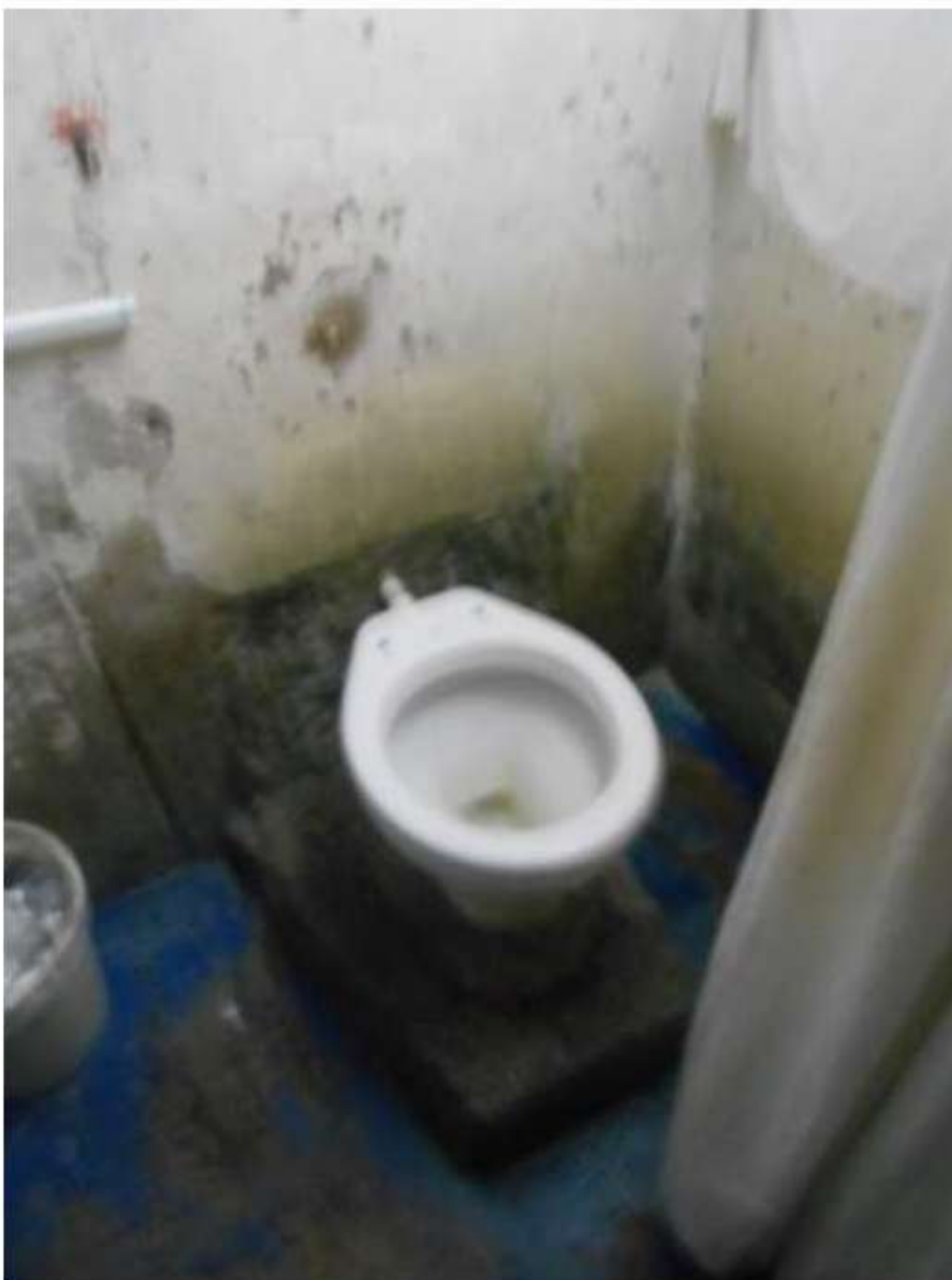
Sanitário dos “faxinas” do Pavilhão A
