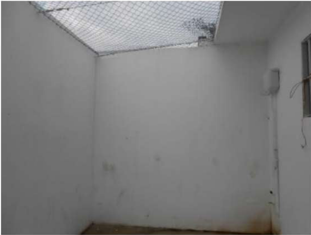
Pátio de Sol da Internação
