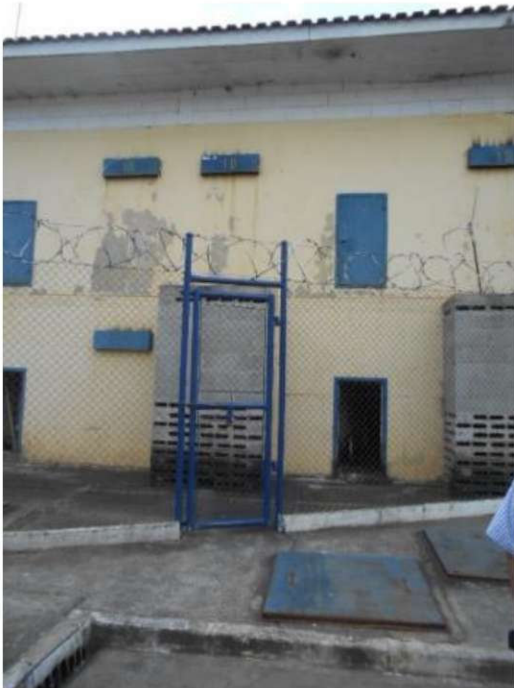
Vista Externa do Pavilhão
