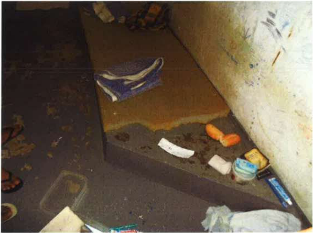
Cela do setor de disciplina e colchão em estado crítico
