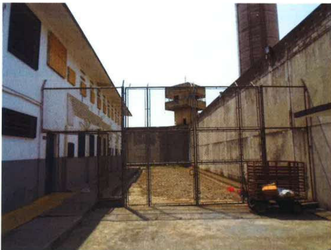
Vista da porta de entrada do CDP (após a passagem pela portaria) – fundo das celas
