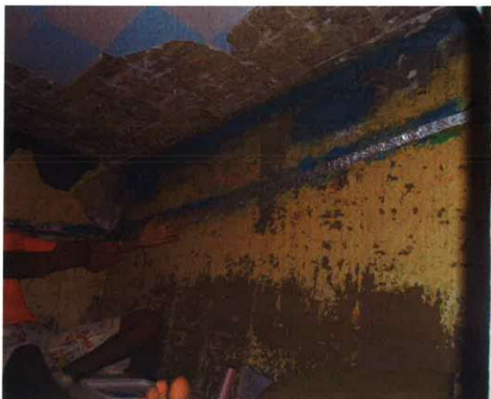
Paredes da cela
