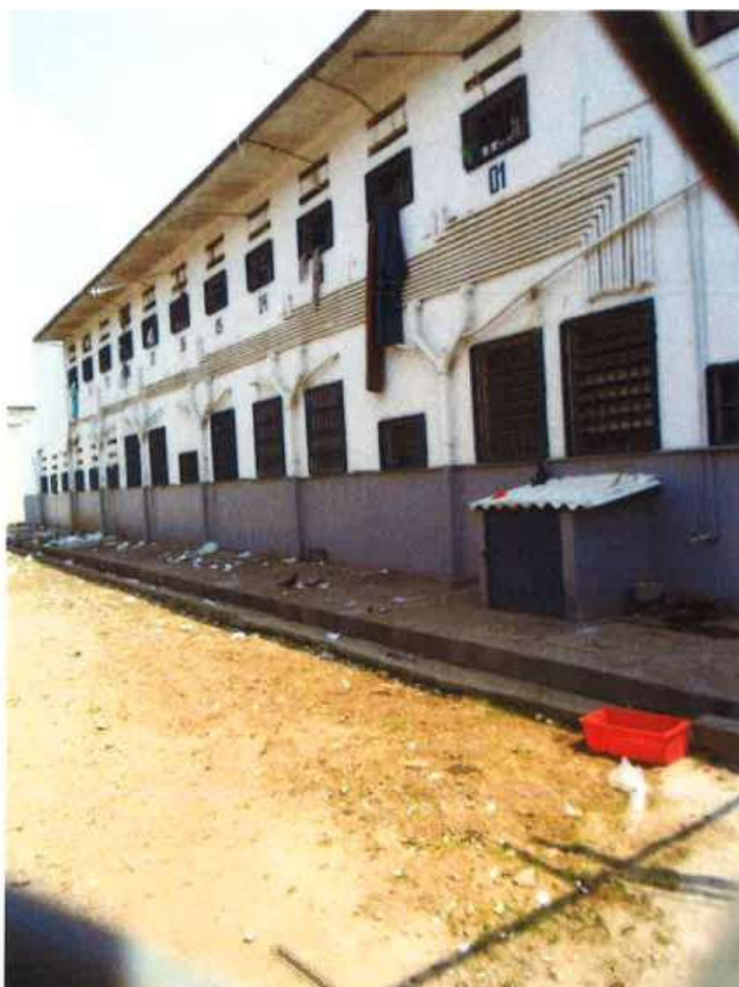
Vista da porta de entrada do CDP (após a passagem pela portaria) – fundo das celas
