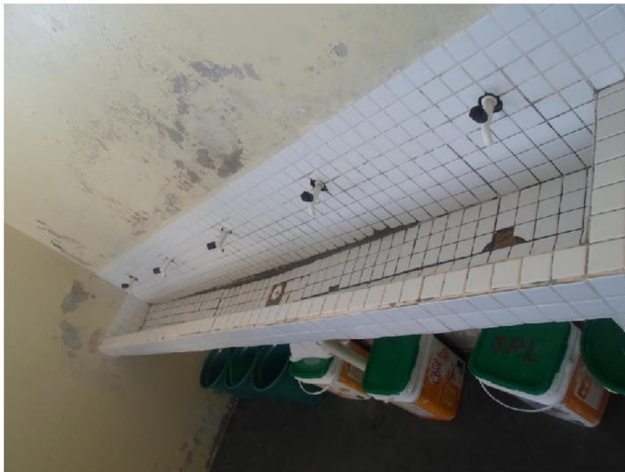
(Foto 09: banheiro da ala de progressão)
