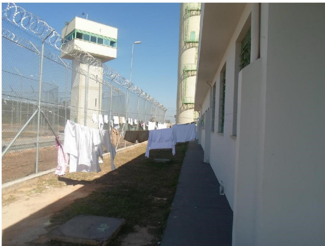
(Foto 04: Lateral do alojamento da ala)
