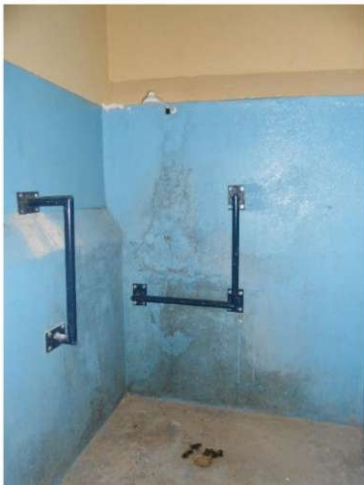
Reforma de raio com acessibilidade
