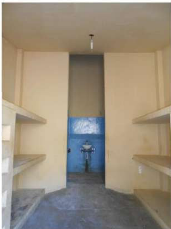
Cela de raio recém reformado
