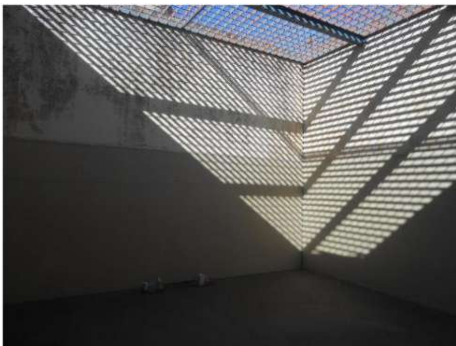
Espaço para banho de sol no setor de seguro
