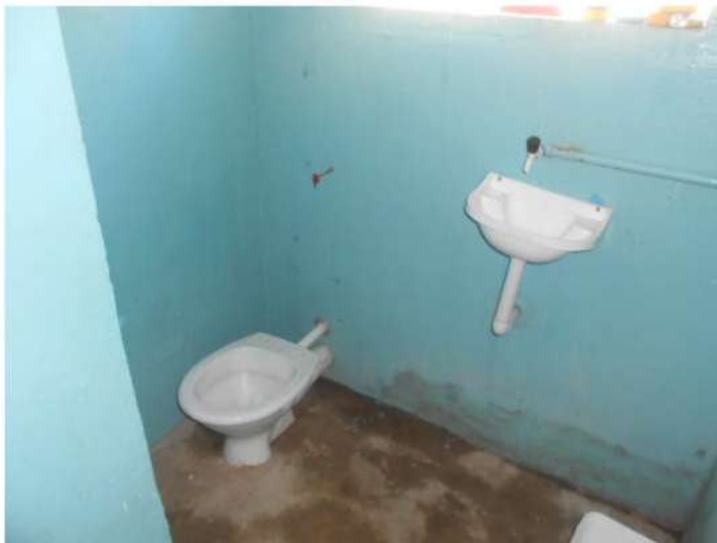
Banheiro de cela do setor de seguro
