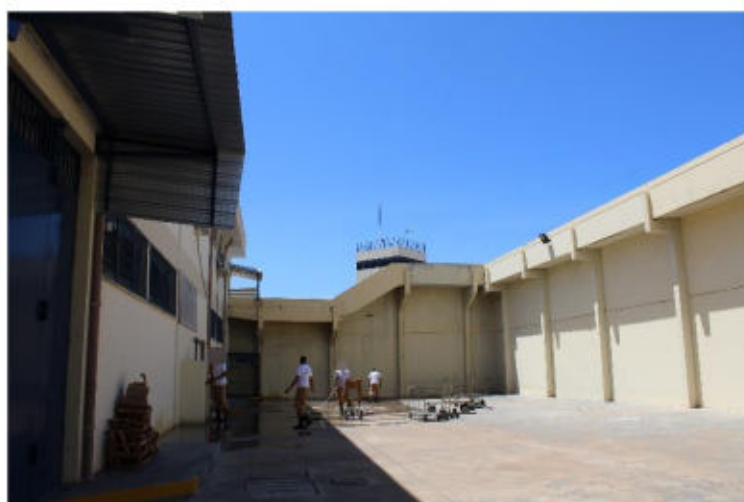
Área externa anterior aos locais de aprisionamento
