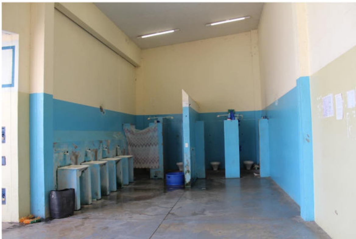
Área do pátio contendo os 4 banheiros externos e os 4 tanques de lavar roupa
