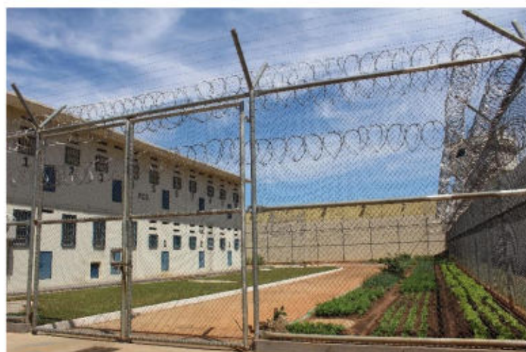
Área externa anterior aos locais de aprisionamento
