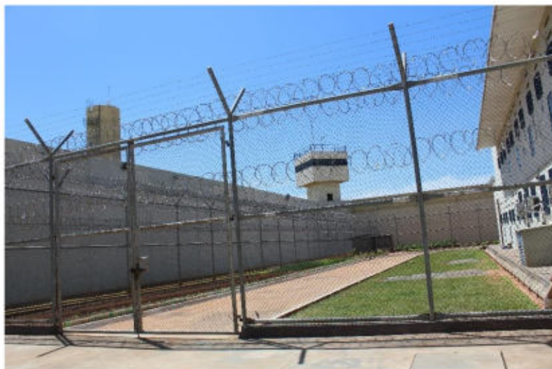
Área externa anterior aos locais de aprisionamento
