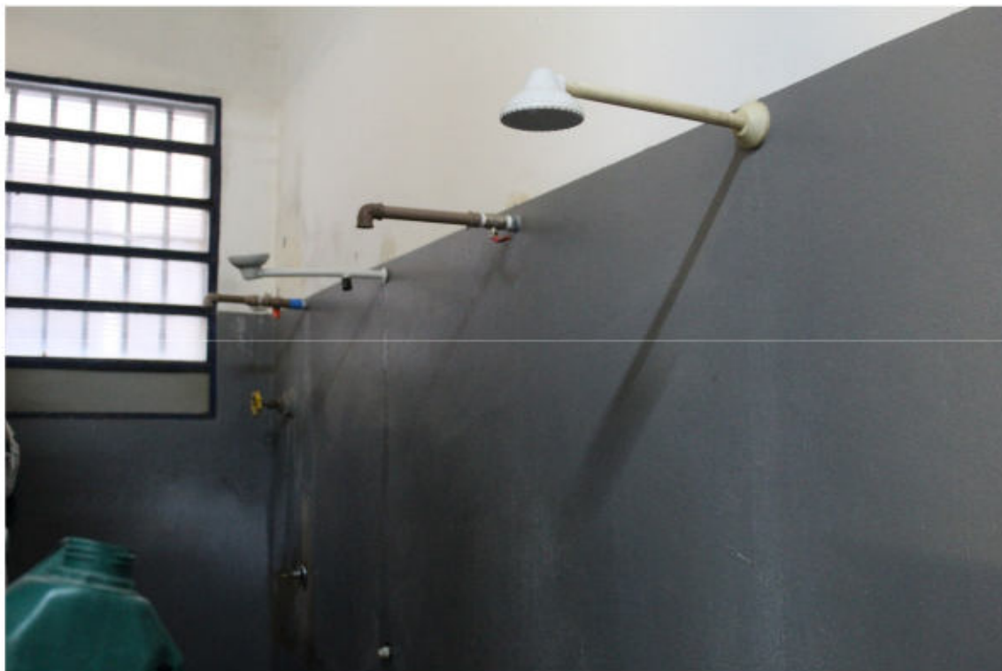
(banheiro da ala de progressão)
