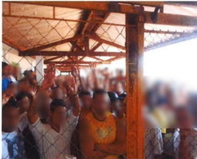
Foto 21 - Portão de entrada para o pátio dos alojamentos
