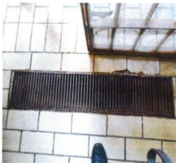
Foto 80 – Ralo vazado na sala de armazenamento de alimentos
