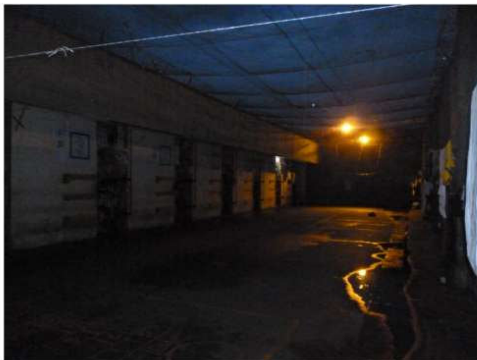
Visão do pátio do setor do convívio e da entrada das celas, onde se pode perceber que as celas são bastante escuras.
