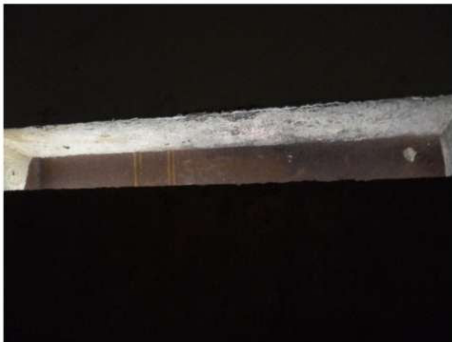
Detalhe da chapa de ferro colocada nas janelas de algumas celas do castigo, o que reduz drasticamente a iluminação e a ventilação, como pode ser observado na foto acima.
