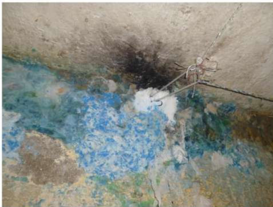
Sabão passado nas paredes pelos presos com o intuito de minimizar os efeitos das infiltrações.
