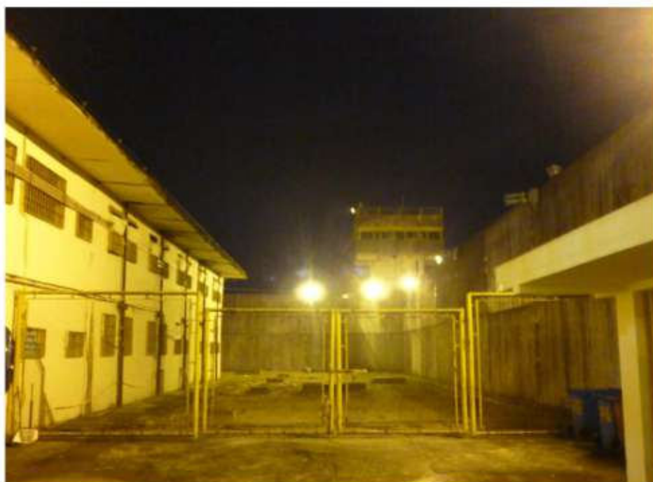
Pátio localizado entre o prédio da administração e o prédio em que ficam os setores de aprisionamento.
