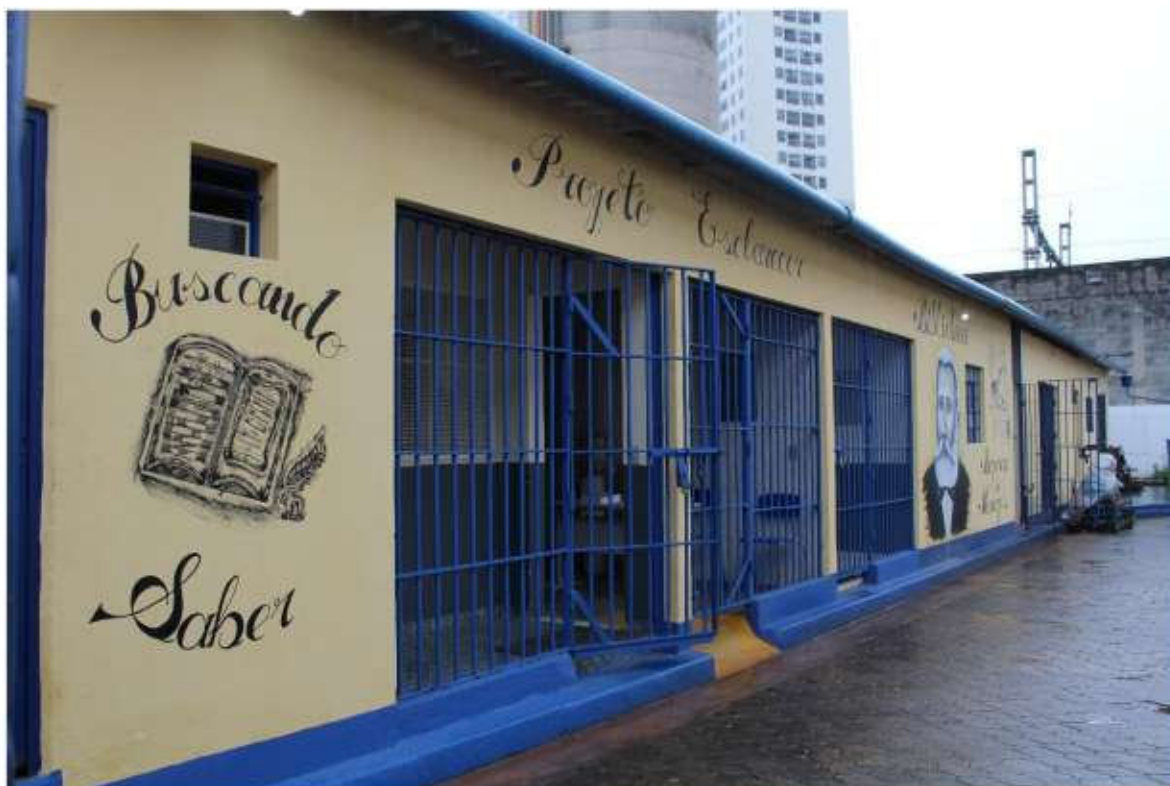
Prédio onde ficam localizadas as salas de aula, biblioteca e oficinas
