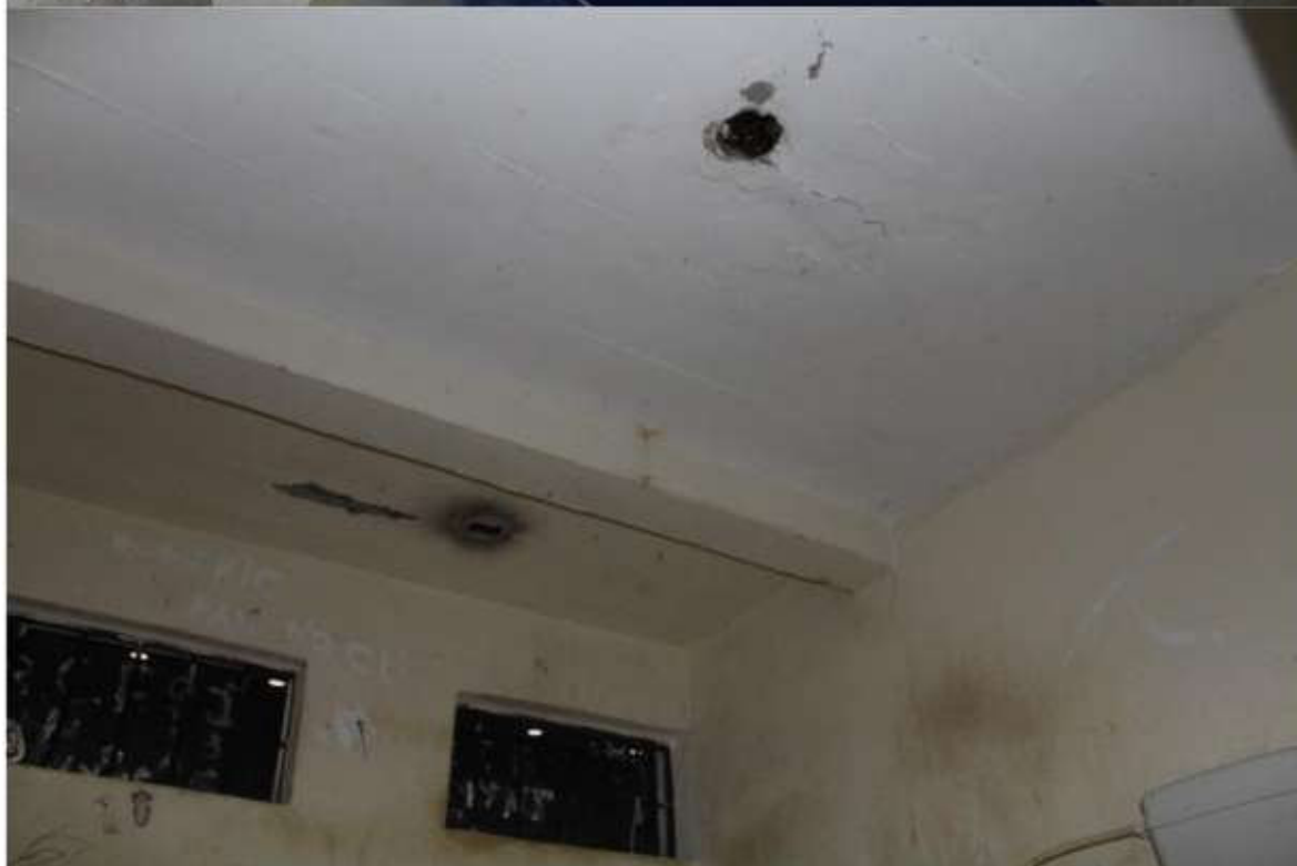
Enfermaria: cela de isolamento (fotos tiradas com flash diante da ausência de iluminação natural ou artificial)
