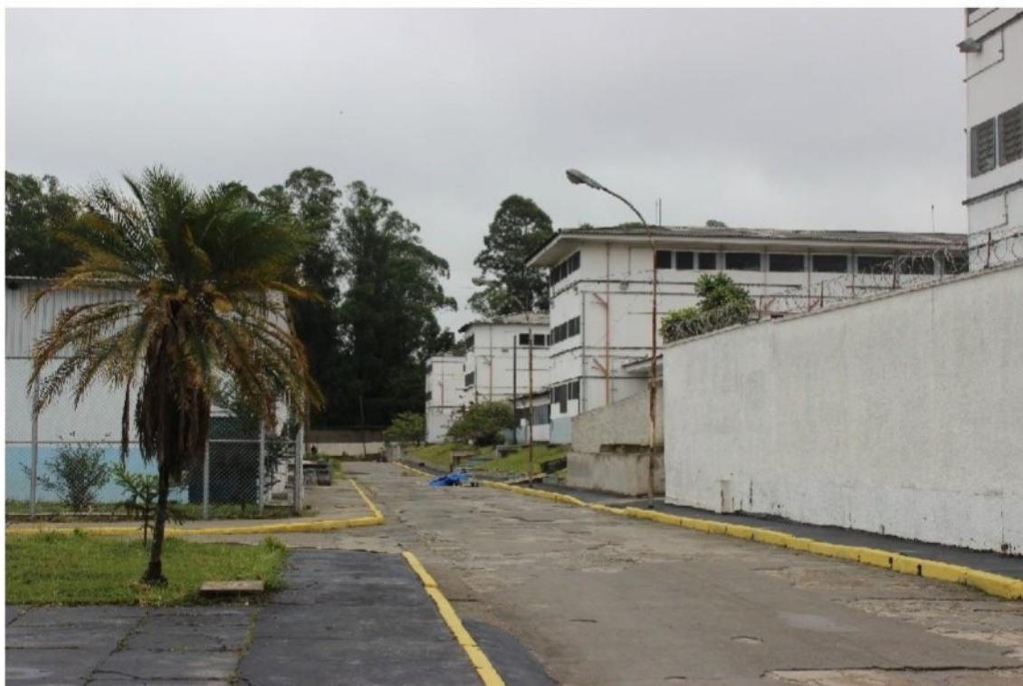
(Visão dos 3 pavilhões habitacionais da unidade prisional)
