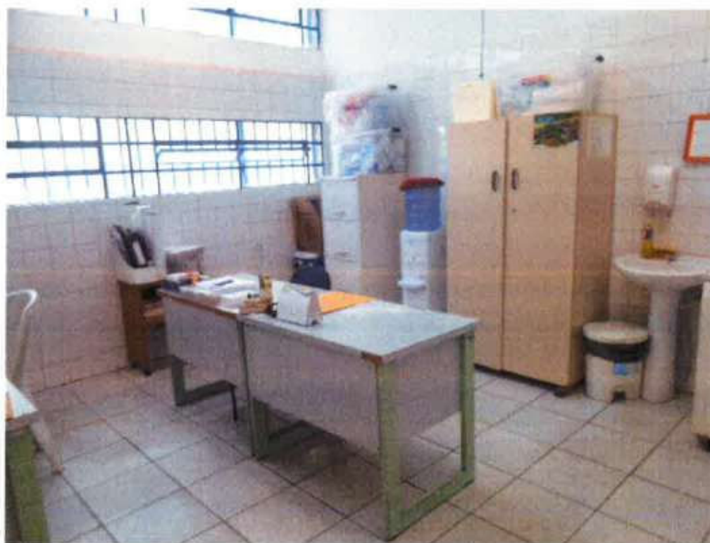
Foto 6 – Sala de enfermaria – em bom estado de conservação.
