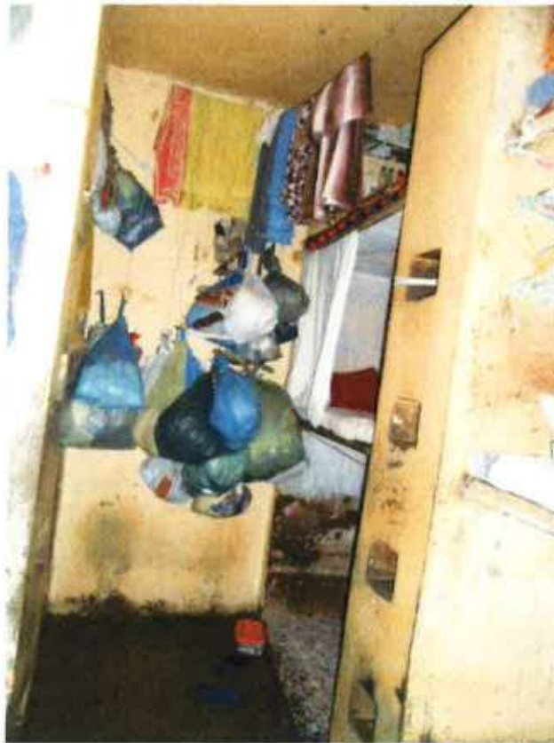
Foto 33 – Cella do raio em mau estado de conservação.
