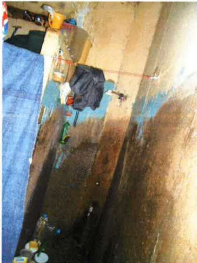
Foto 34 – Cella dos sentenciados com chuveiro de água fria. A água quente era disponibilizada apenas para a cela dos "faxinas".
