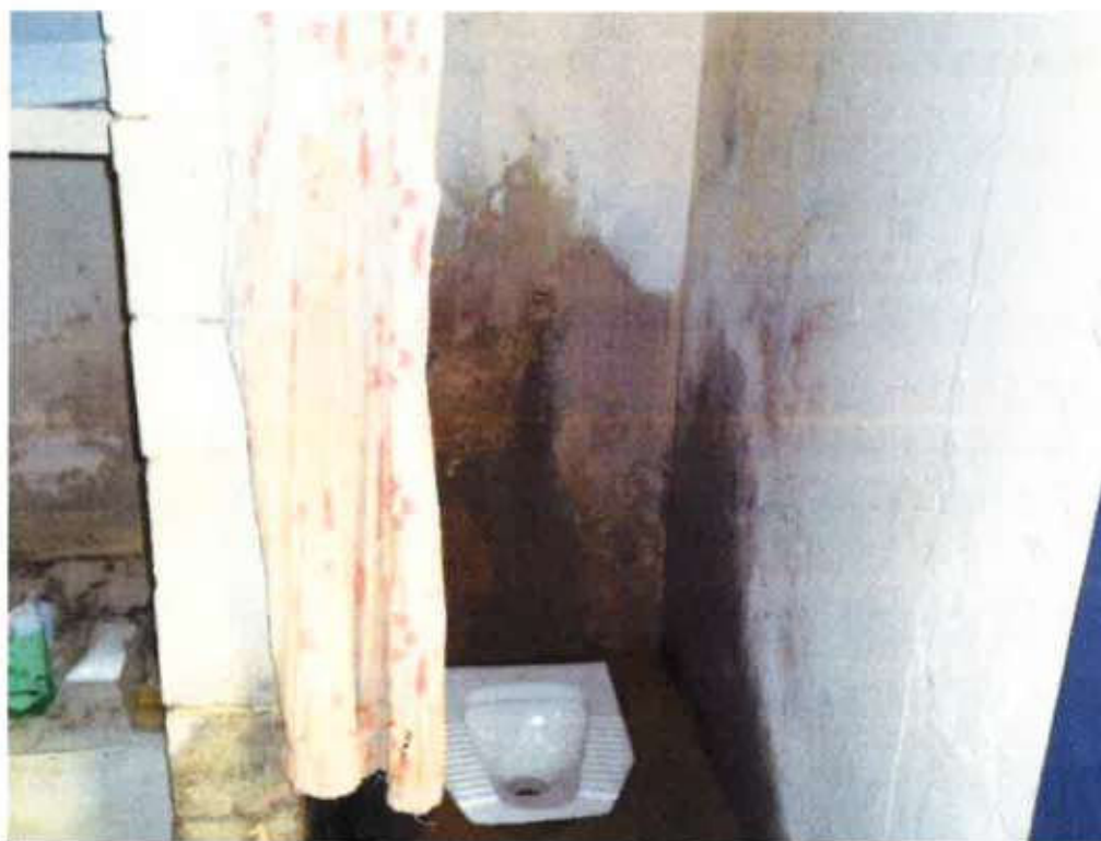
Foto 58 – Cella do setor de inclusão.
