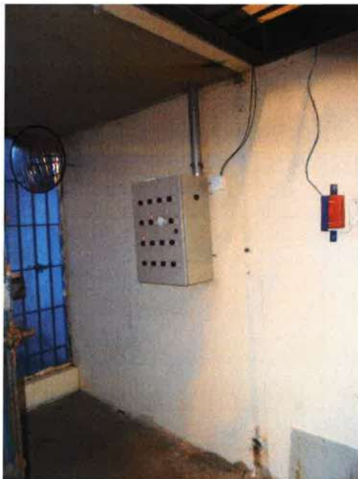
Foto 53 – Setor de energia e controle de portas do pavilhão.
