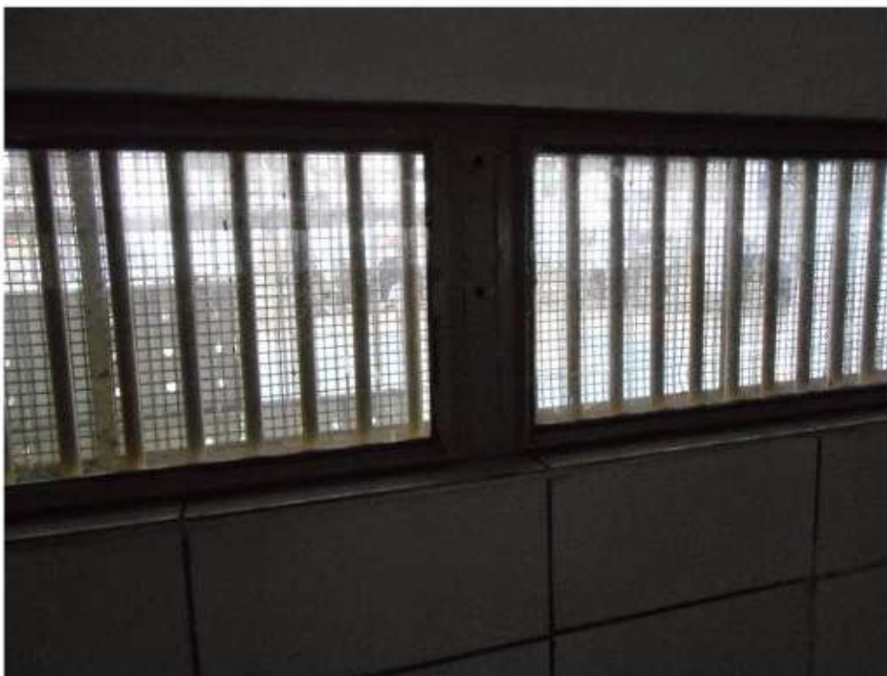
Observatório (detalhe da sala de controle dos raios)
