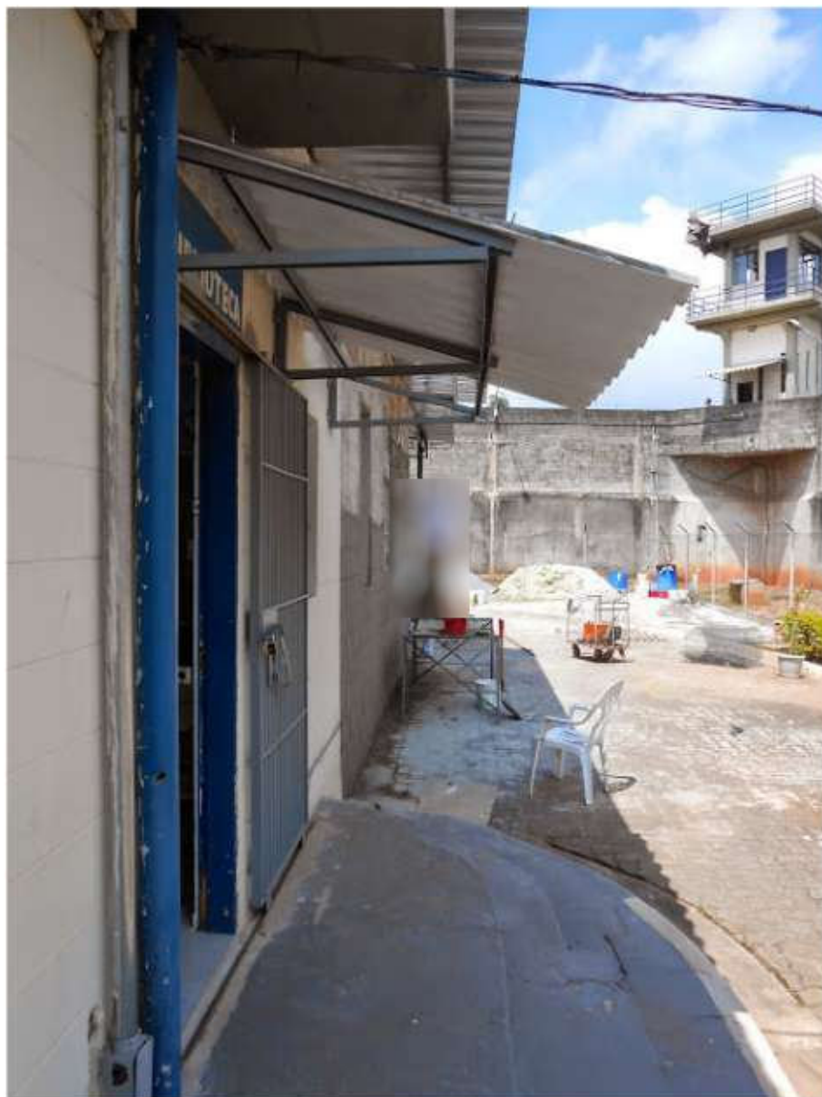
Reforma para ampliação da sala de estudos
