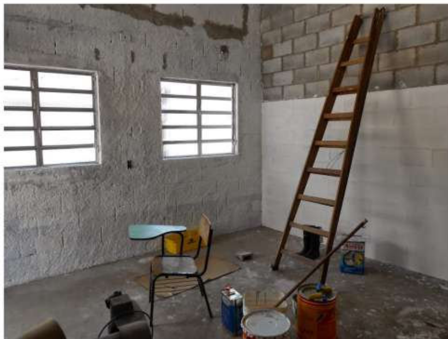
Reforma para ampliação da sala de estudos
