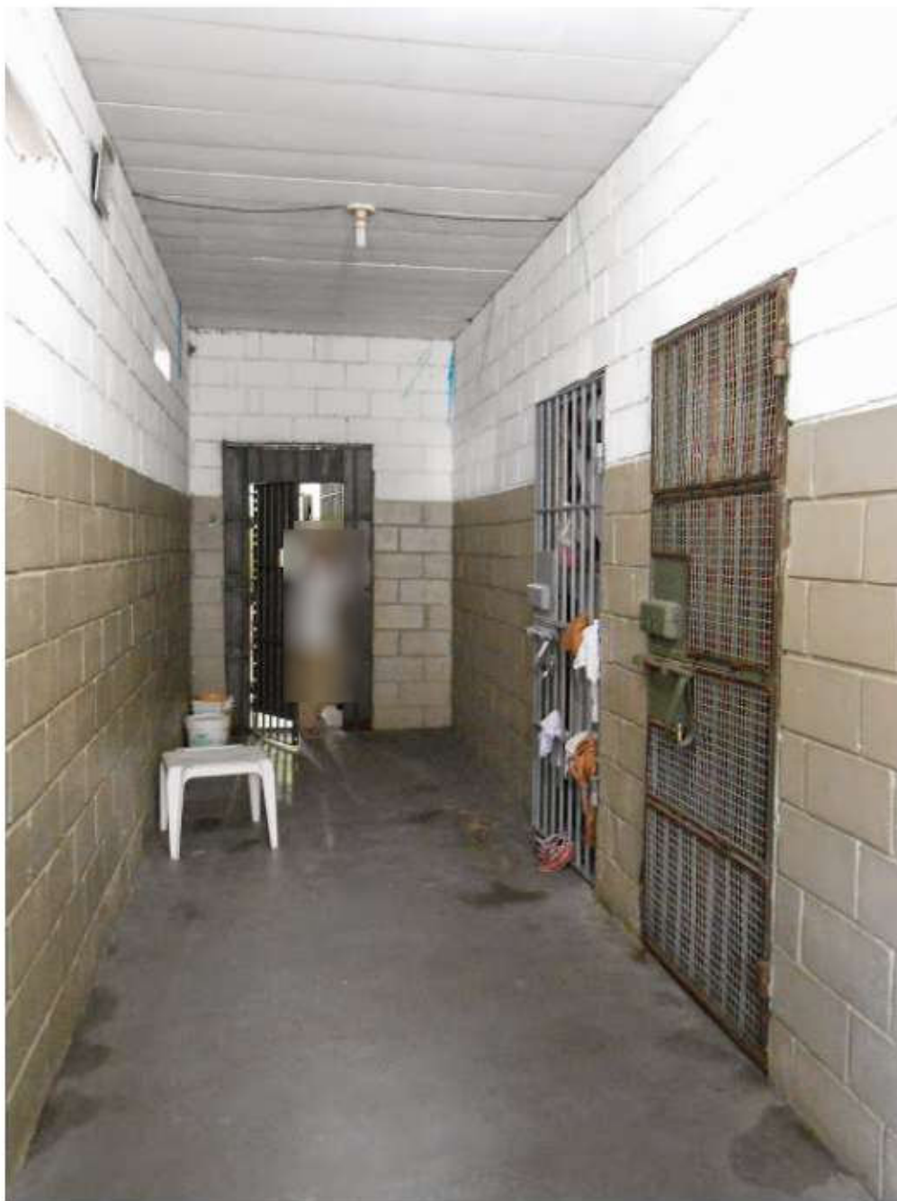
Corredor de acesso ao setor de “seguro” (medida preventiva de segurança pessoal), à cela dos presos que trabalham internamente e ao almoxarifado
