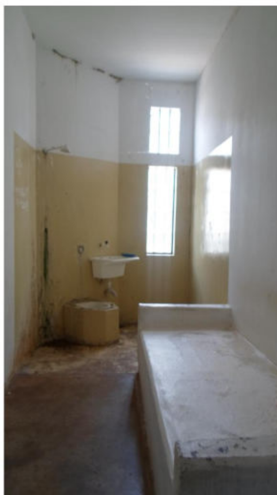
Cela de isolamento no setor da saúde
