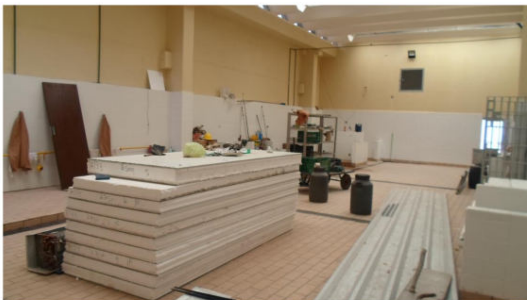
Cozinha em reforma
