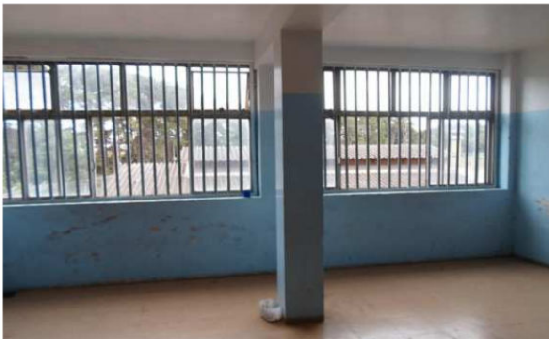
Foto 16. Entrada do raio. Quarto andar.
