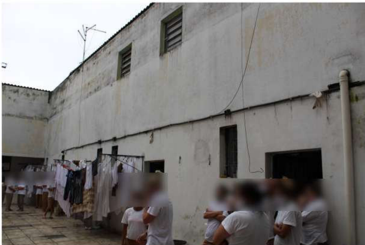
Vista da lateral direita do pátio
