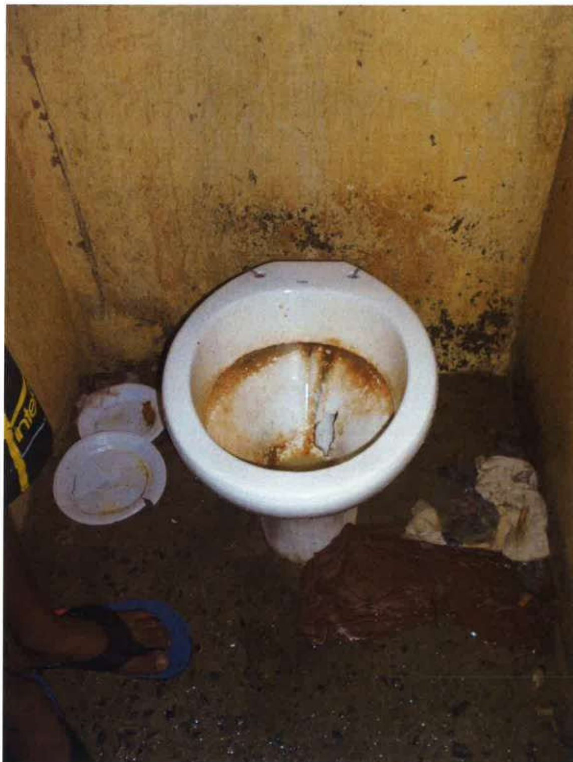
Foto 26 – Situação de sanitário em um dos raios com condições horrível de higiene
