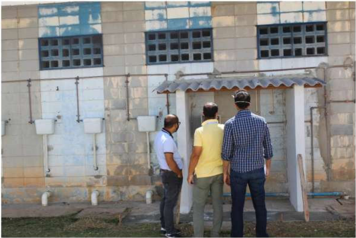
Futuras instalações do aquecimento do chuveiro
