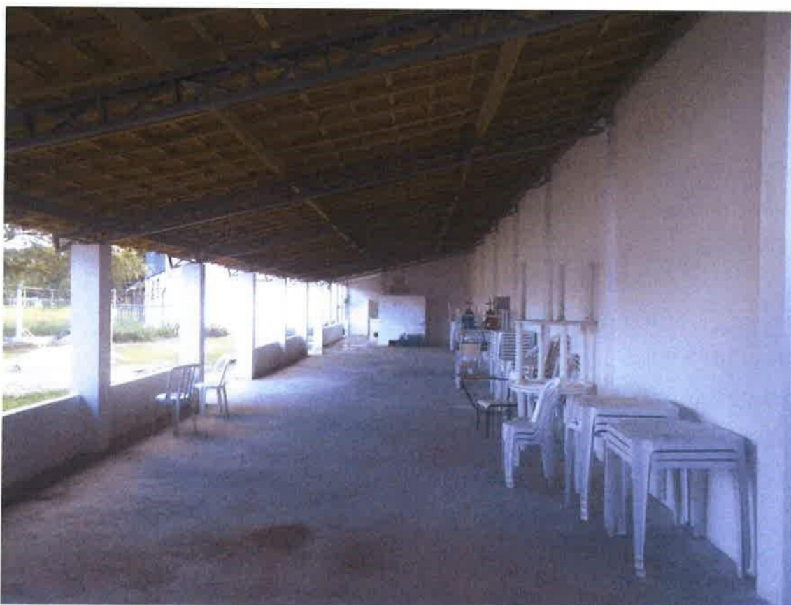
(Registro fotográfico área externa da ala de progressão – onde se realizam as visitas)
