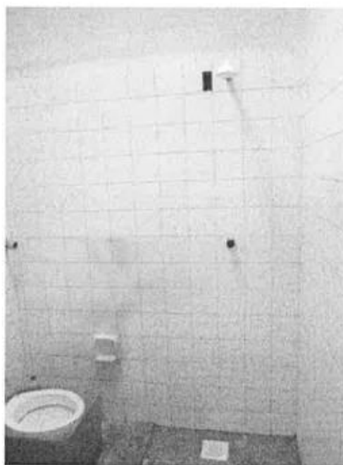
Foto 2: Banheiro da Cella de Isolamento
