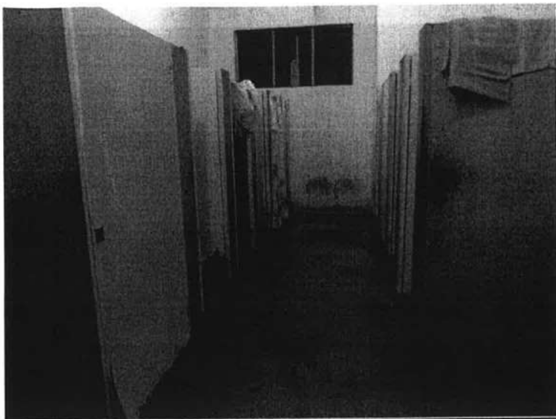
Banheiro do setor de semiaberto
