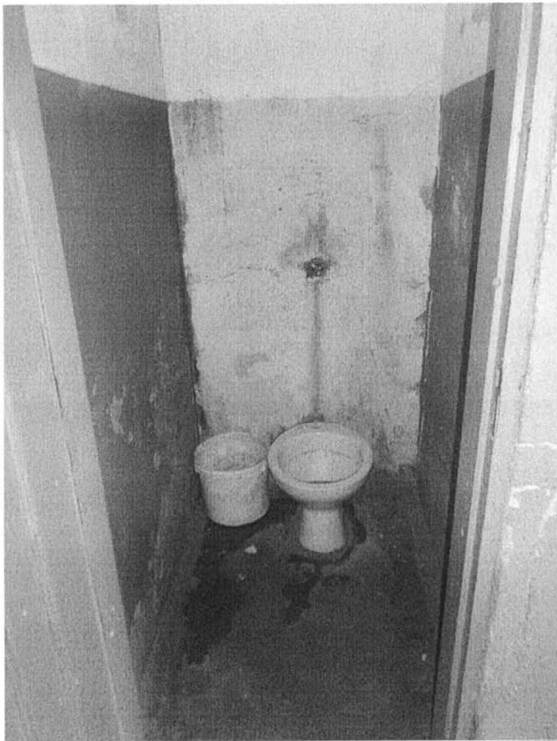
Banheiro localizado no pátio
