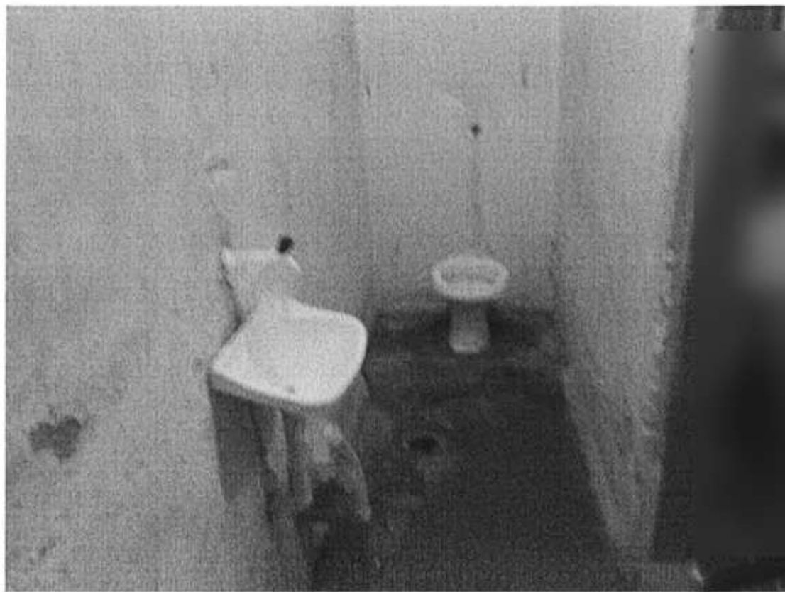
Banheiro da cela de inclusão
