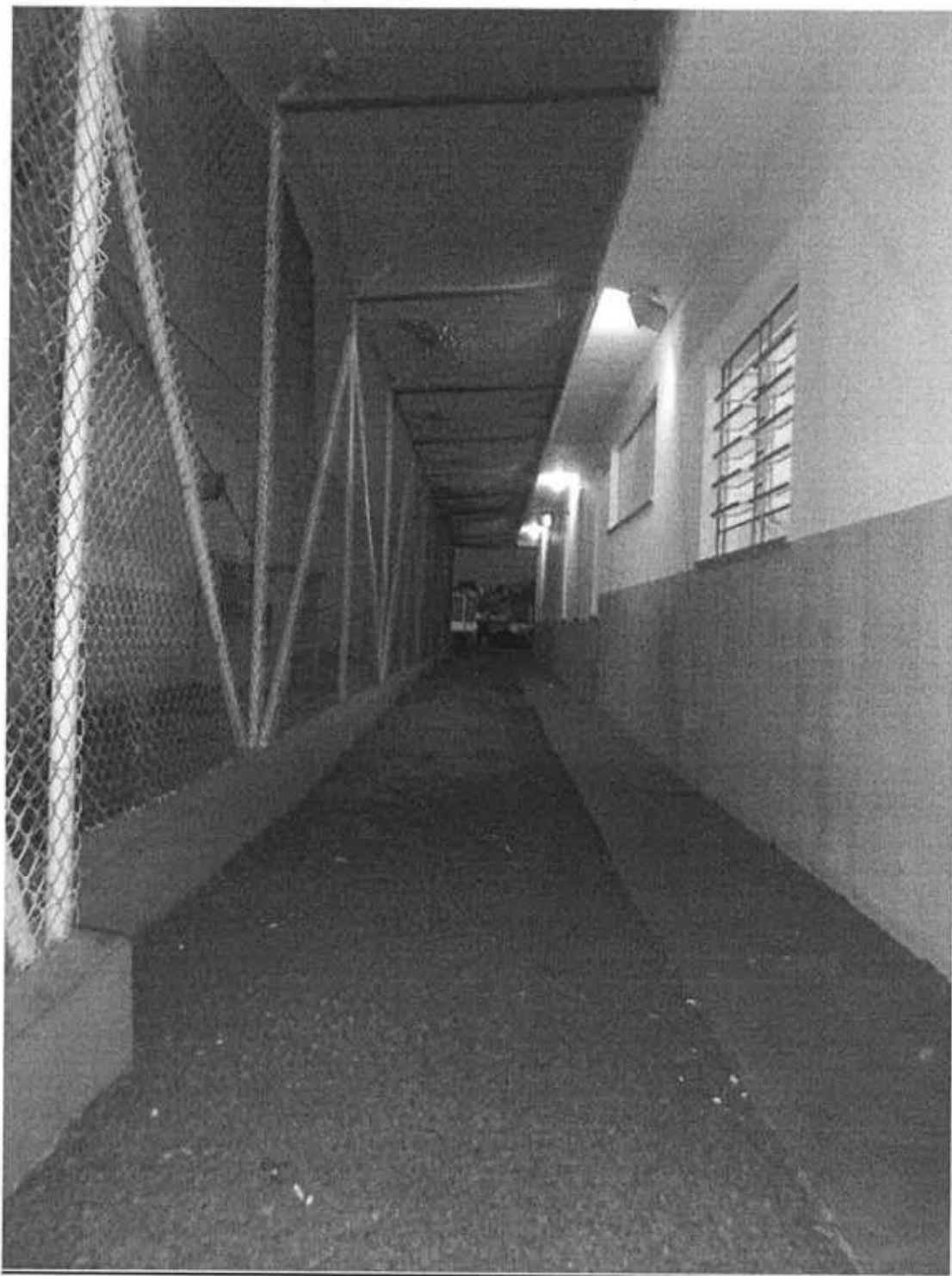
Área externa do setor de semiaberto
