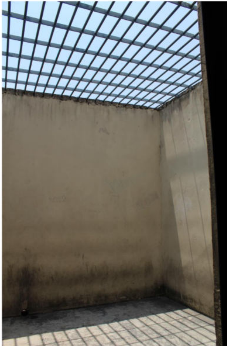
(Local de banho de sol dos presos localizados no setor de disciplina).
