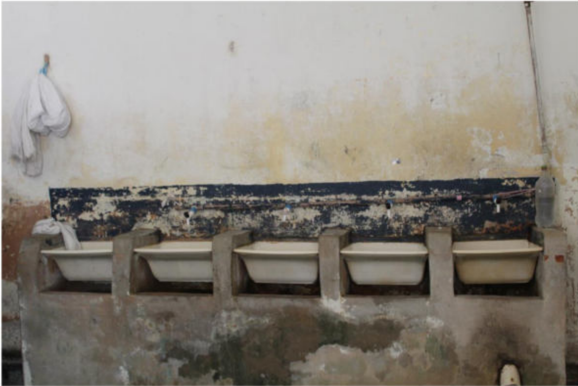
Tanques localizados na área externa das celas.
