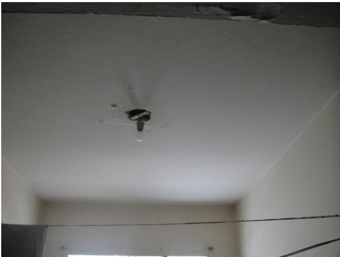
Lâmpada em cela do pavilhão 1.
