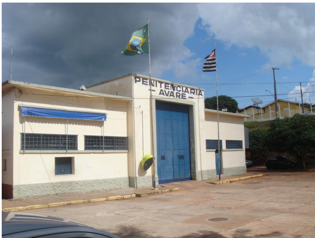
Entrada principal da Penitenciária I de Avaré.
