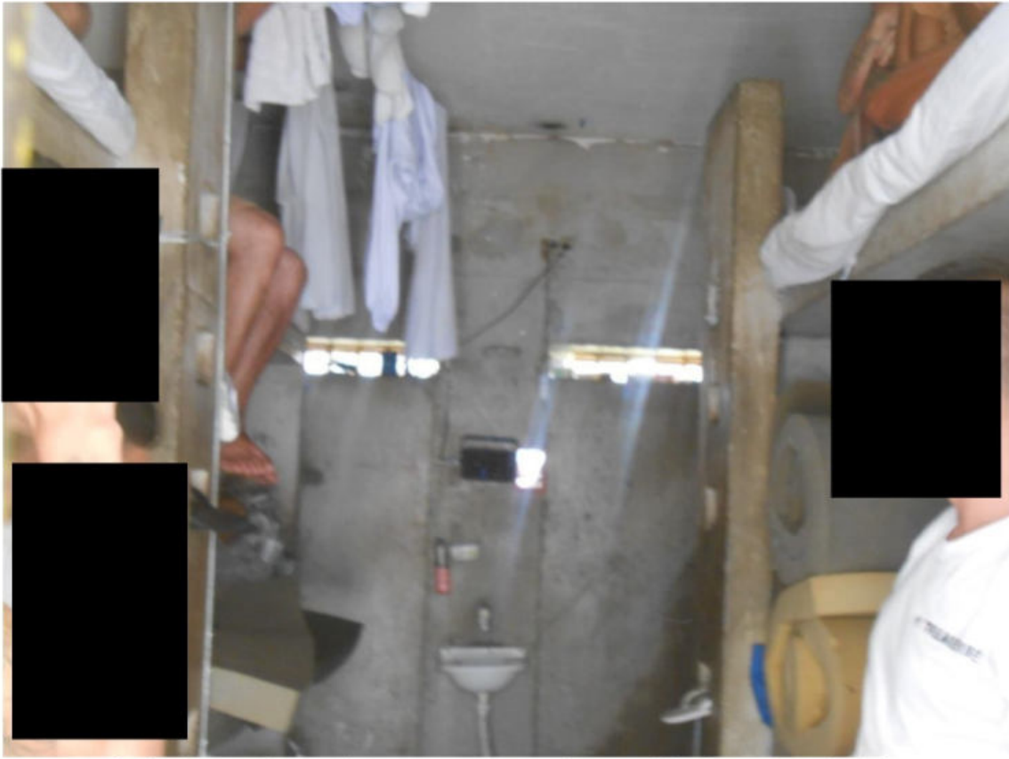
(Cela do setor de convívio – pequenas janelas que dificultam a ventilação)
