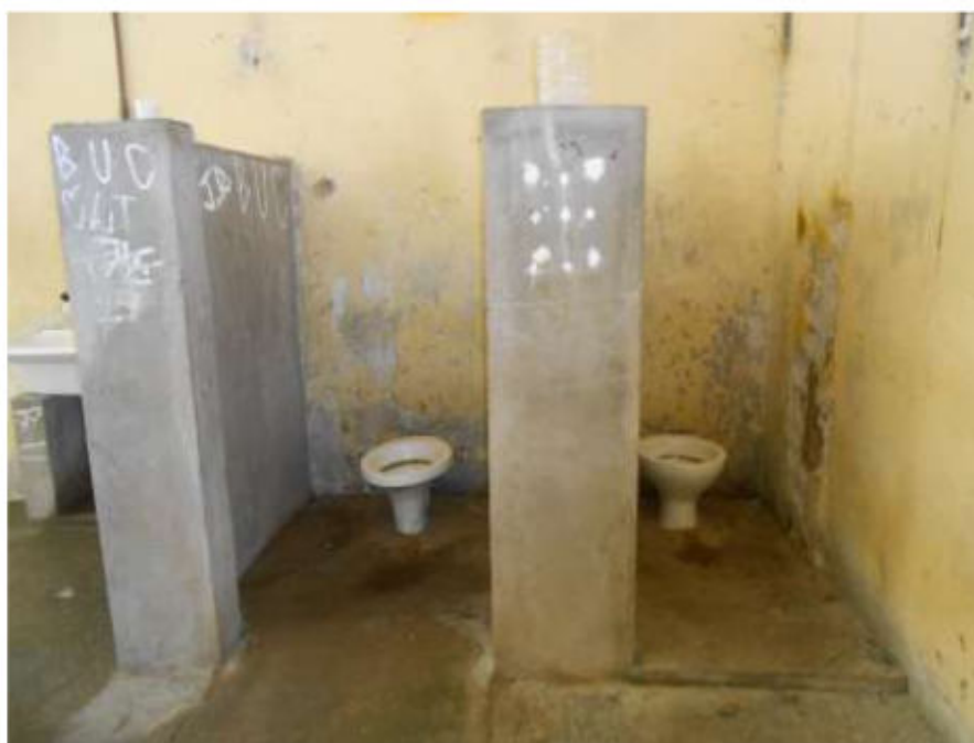
(sanitários na ala de progressão)
