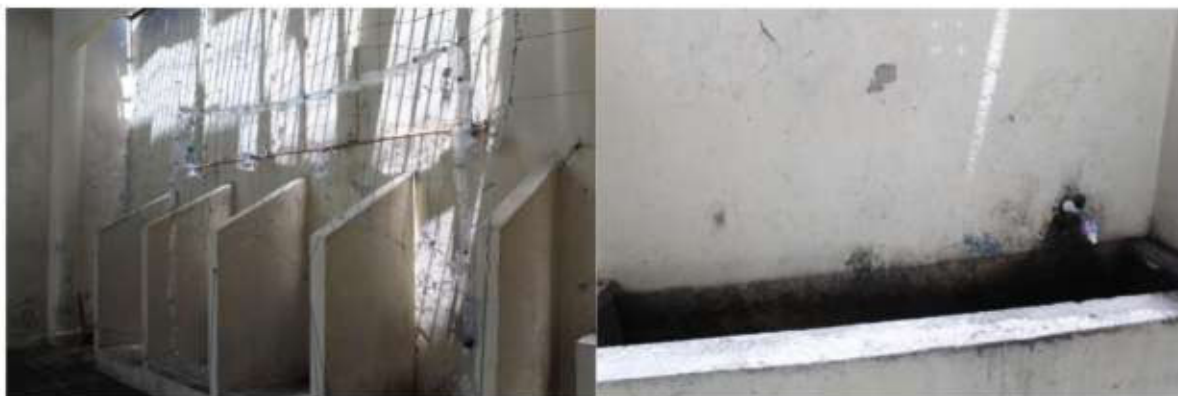
Banheiro no pátio da área comum (quarto andar de cada prédio)
